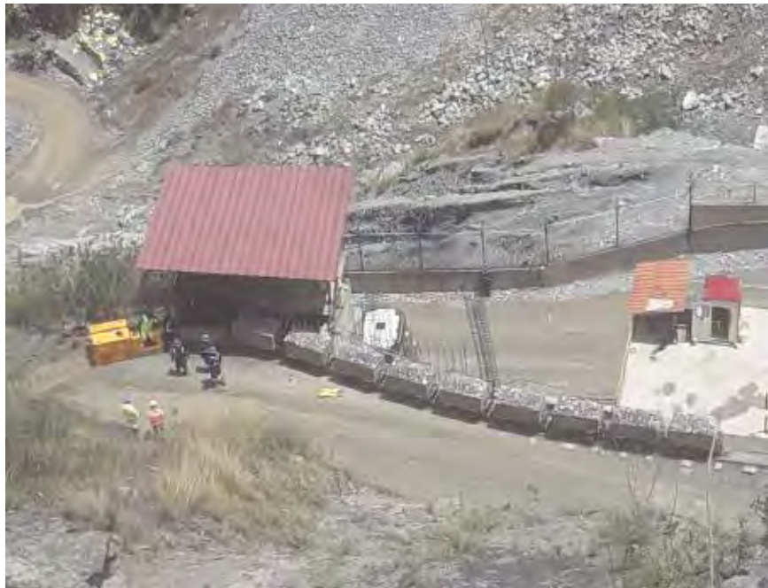
Figura 19. descarga en la tolva locomotora y carritos mineros U-35
