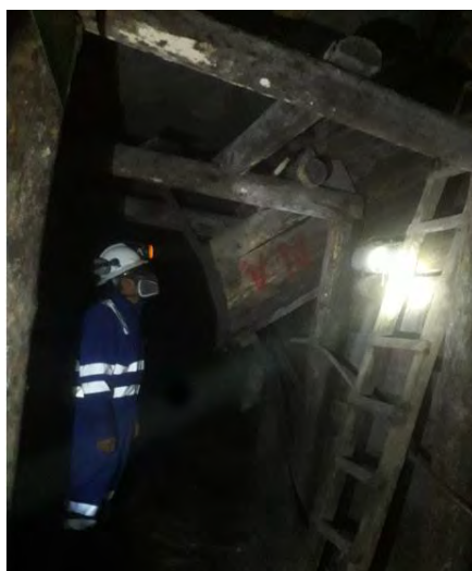
Figura 20. Sosténimiento con cuadro de madera en la galería S 0160
