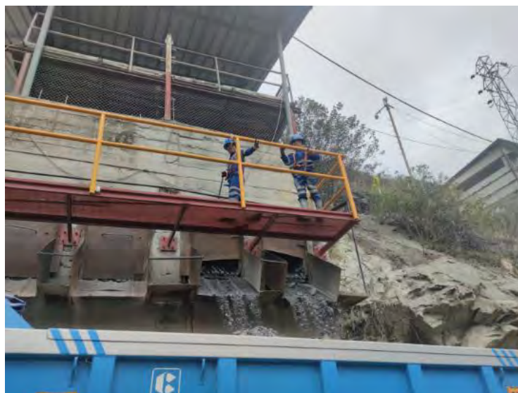
Figura 18. Tolva de Superficie en el nivel 2670 y carguío a volquete de 20 TN
