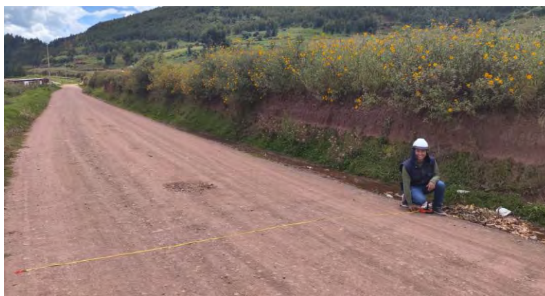
Fotografía 3 Medición del ancho de vía en la carretera CU-905.
