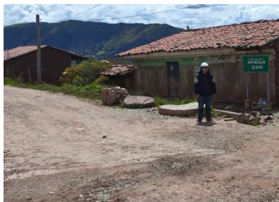
Fotografía 9 Reconocimiento en campo del estado de la vía CU-902
