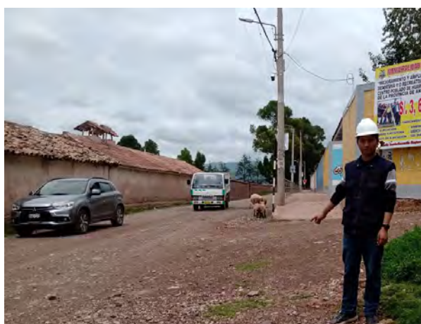
Fotografía 12 Tramo final (llegada) de la vía Zurite-Huarocondo
