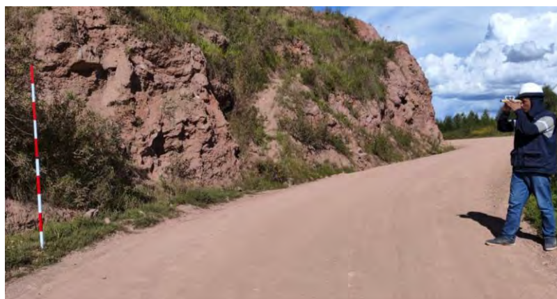
Fotografía 6 Medición del peralte en curvas usando el eclímetro, vía CU-905.
