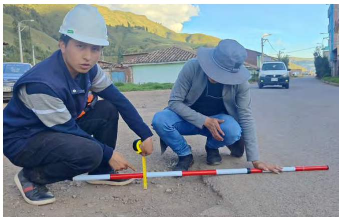
Fotografía 7 Medición del espesor de la vía asfaltada CU-110
