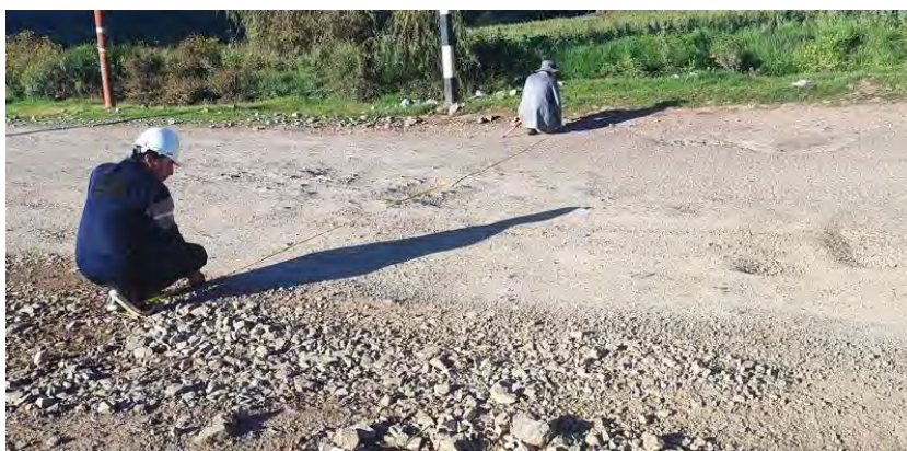
Fotografía 2 Medición del ancho de vía en la carretera CU-902
