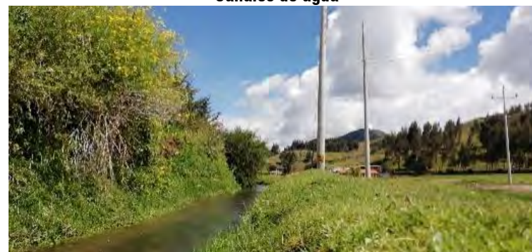
Imagen N.º 143: Canales de agua
