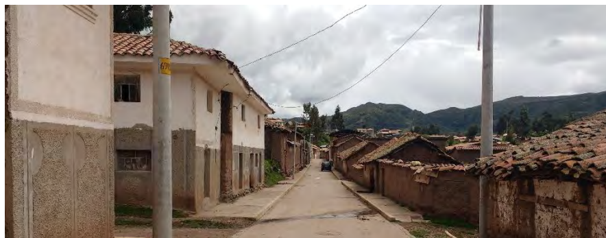
Imagen N.º 018: Material de construcción predominante en adobe, ubicados en el barrio de Urinsaya dentro del ámbito de intervención
