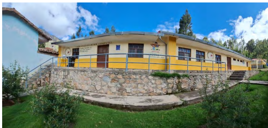
Imagen N.º 056: Laboratorio de control ambiental
