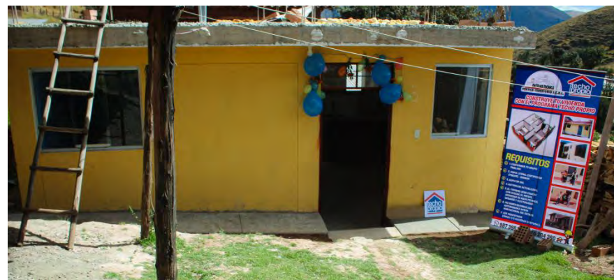
Imagen N.º 024: Módulo de vivienda del programa techo propio
