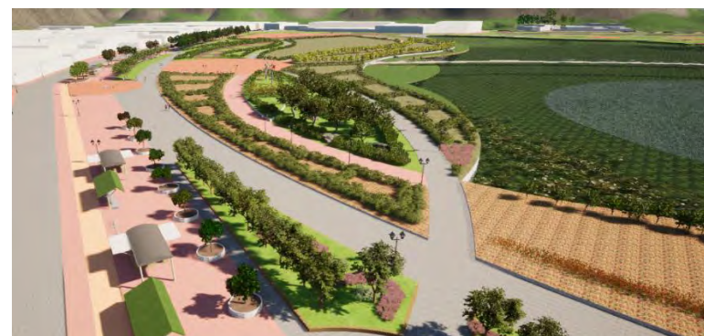
Imagen N.º 136: Vista de las áreas verdes y recuperación de la laguna
