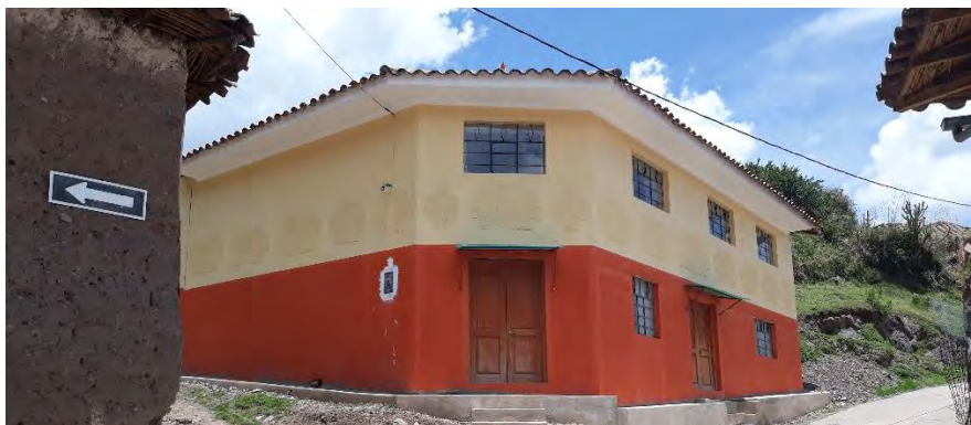
Imagen N.º 020: Estado de conservación predominante en todos los barrios y sectores es el regular dentro del ámbito de intervención
