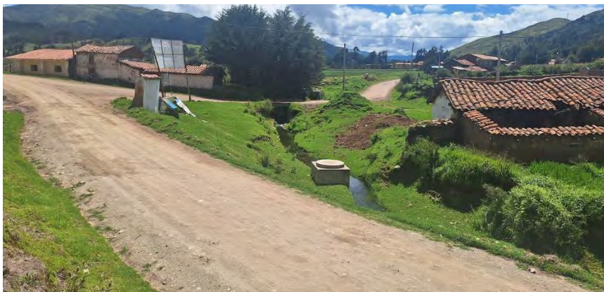
Imagen N.º 063: Buzones de desagüe
