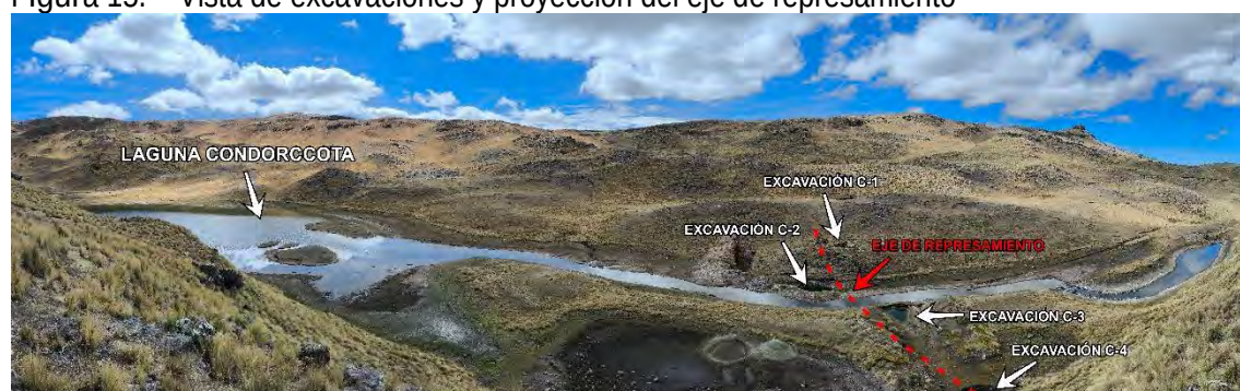
Figura 15. Vista de excavaciones y proyección del eje de represamiento
