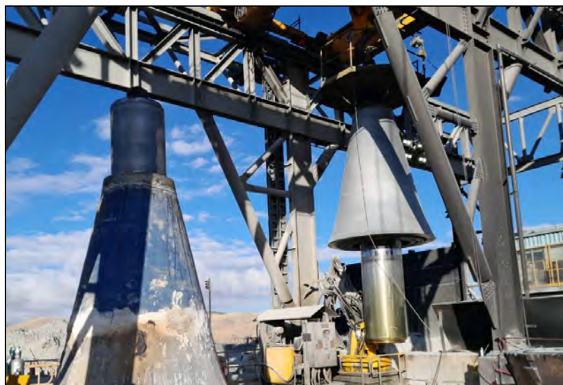
Figura 1.1. Desmontaje del Eje Principal de una Chancadora.
