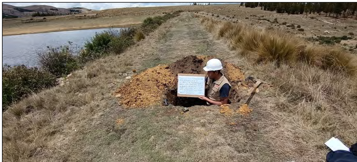
Figura 54. Apertura de calicata C-01 en el núcleo de la presa.
