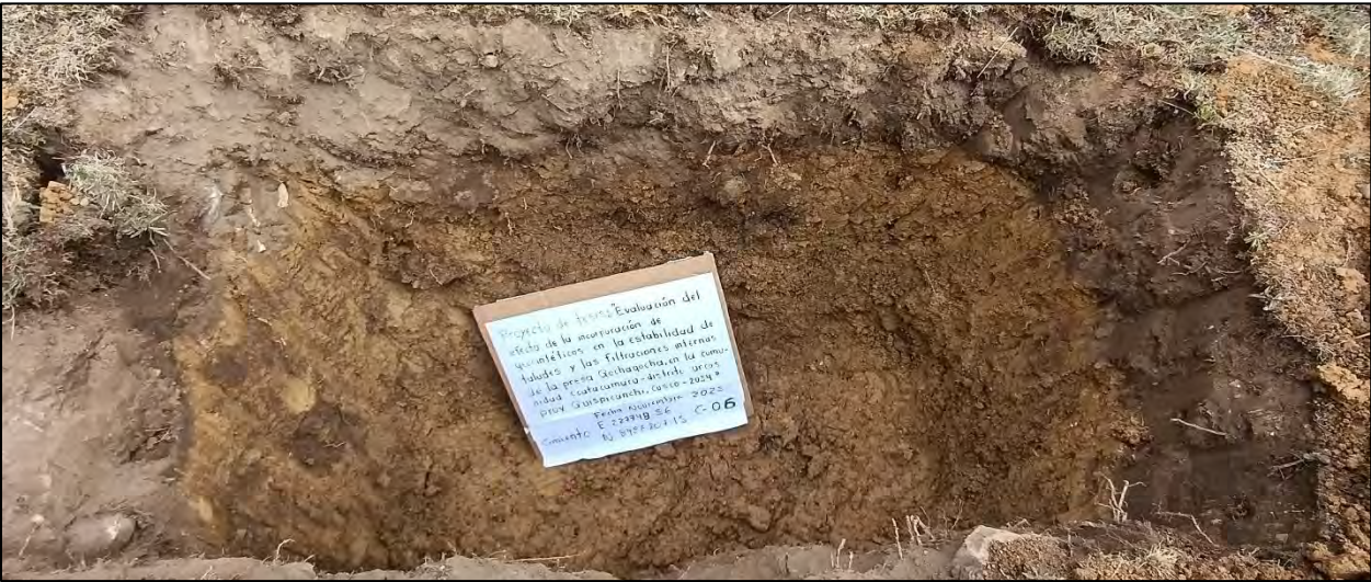
Figura 57. Apertura de calicata C-06 en el cimiento de la presa.
