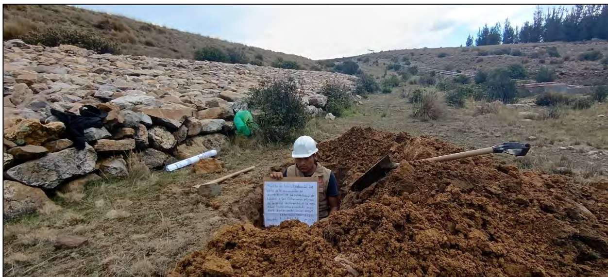
Figura 56. Apertura de calicata C-04 en el cimientó de la presa.
