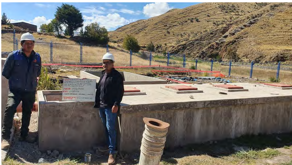
Anexo 54. Evidencia de la construcción del pozo séptico, lecho de secado en la PTAR 3 de la obra CUI 2498177.
