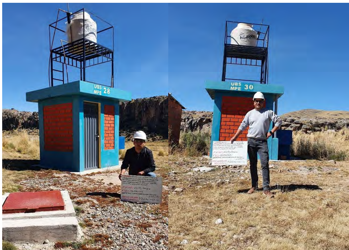
Anexo 68. Evidencia la ejecución de Unidades Básicas de Saneamiento (UBS) N° 28 y N° 30 con su kit de accesorios: inodoro y lavatorio, también se aprecia el biodigestor y el poso de absorción de la obra CUI 2609075.
