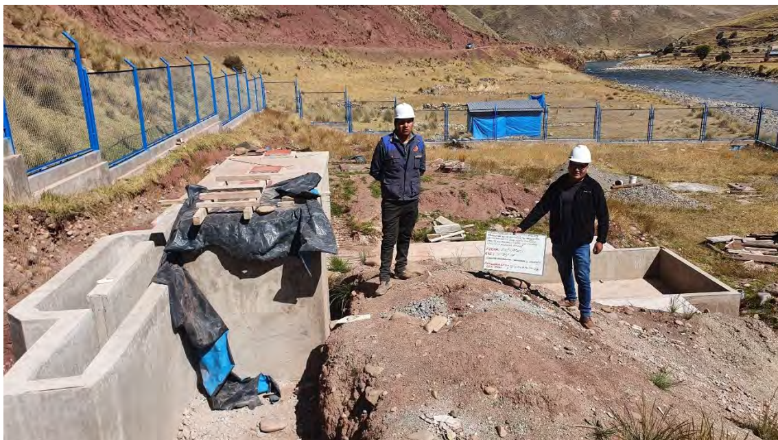
Anexo 54. Evidencia de la construcción del pozo séptico, lecho de secado en la PTAR 3 de la obra CUI 2498177.
