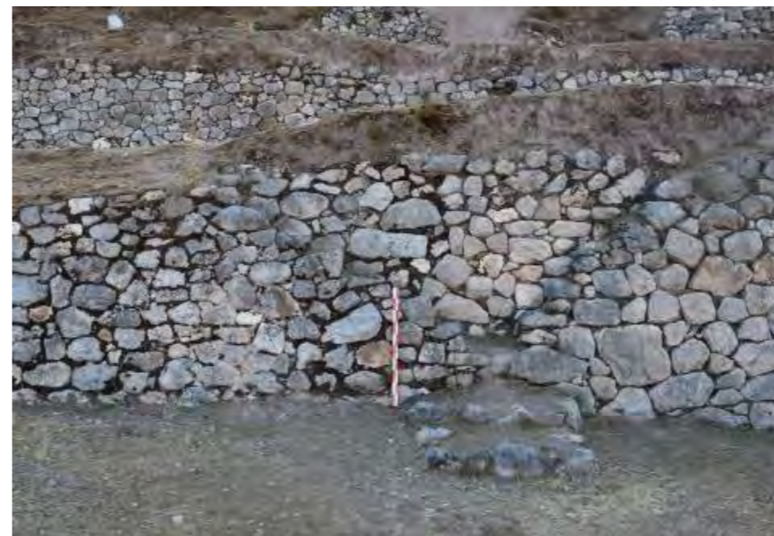
VISTA GENERAL DE LA ESCALINATA EN ANDEN (E-02)
