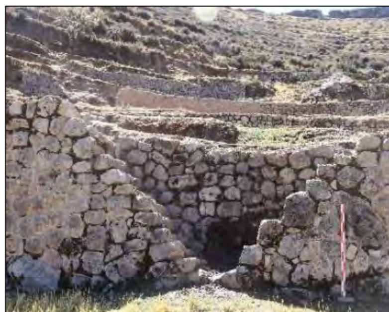
VISTA GENERAL DE LA ESCALINATA EN ANDEN (E-02)
