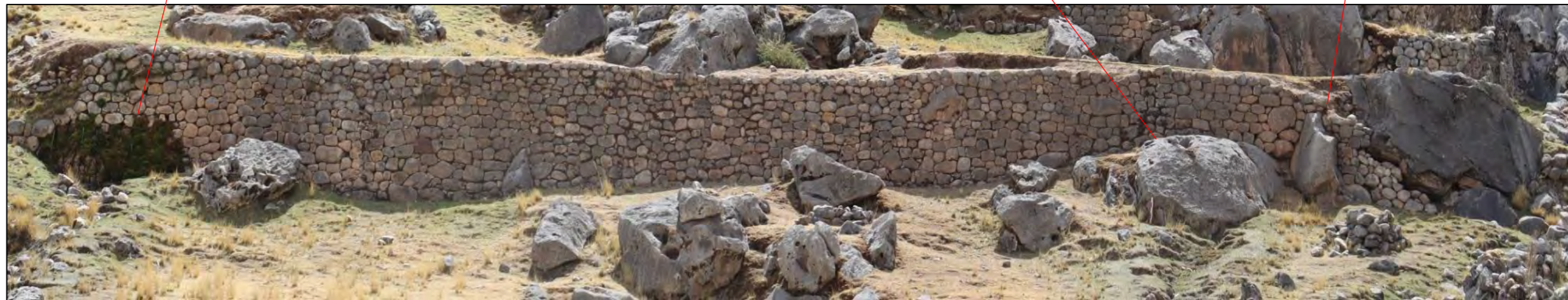
VISTA GENERAL DE LA ESTRUCTURA (MURO 01)
