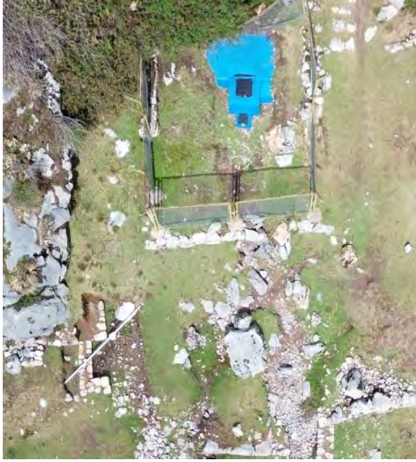
Captación de agua (02) del manantial (M-2)
