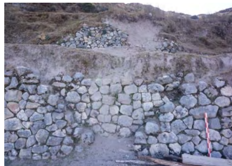
VISTA GENERAL DE LA ESCALINATA EN ANDEN (E-01)
