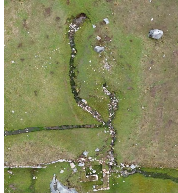
Captación de agua (03) del manantial (M-3)
