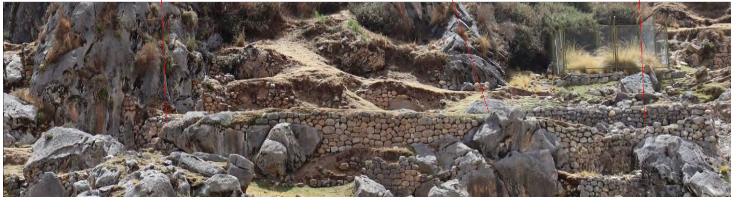
VISTA GENERAL DEL MURO (03)
