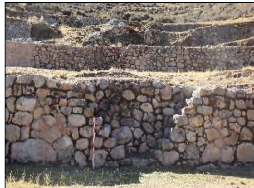
VISTA GENERAL DE LA ESCALINATA EN ANDEN (E-02)
