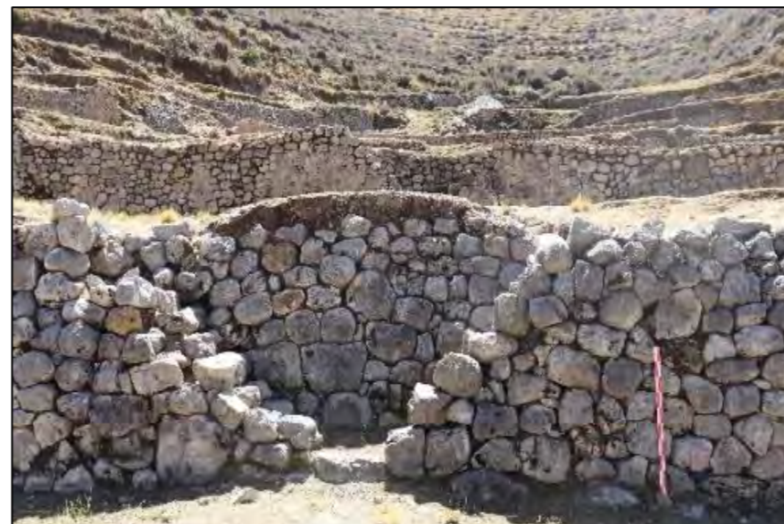
VISTA GENERAL DE LA ESCALINATA EN ANDEN (E-02)
