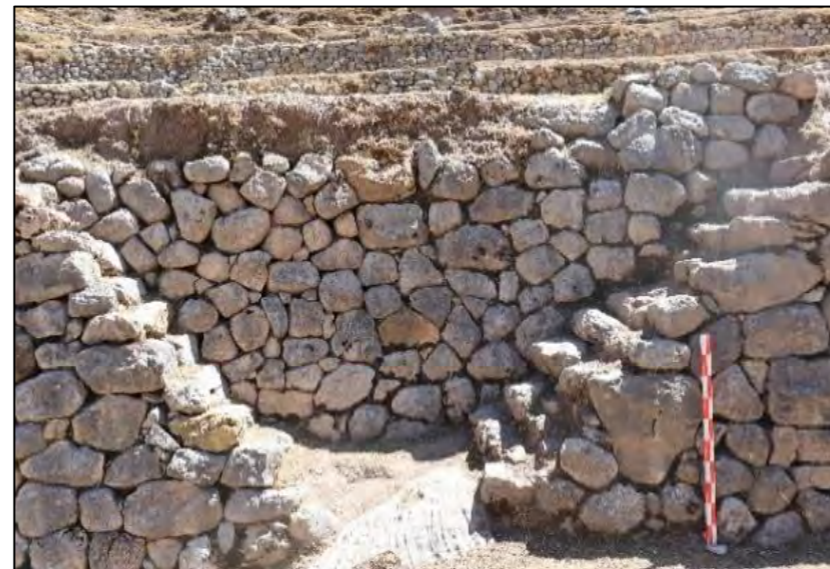
VISTA GENERAL DE LA ESCALINATA ANDEN (E-02)
