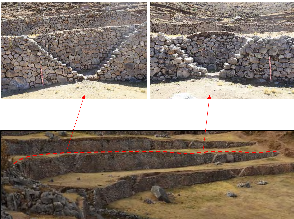
Escalinata de doble tramo del cuarto andén
