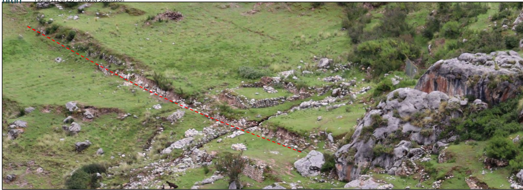
VISTA GENERAL DE LAS ESTRUCTURAS
