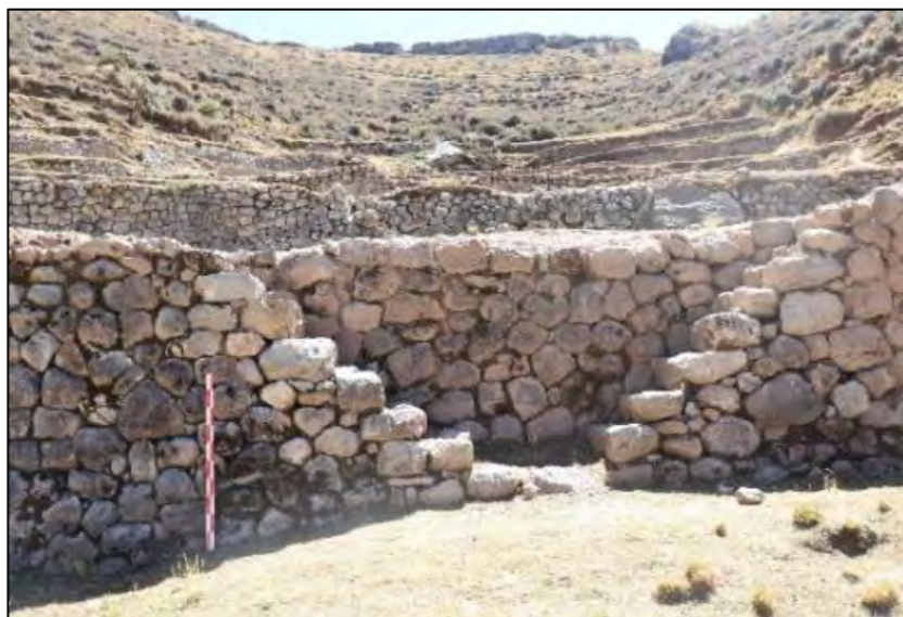
VISTA GENERAL DE LA ESCALINATA ANDEN (E-01)
