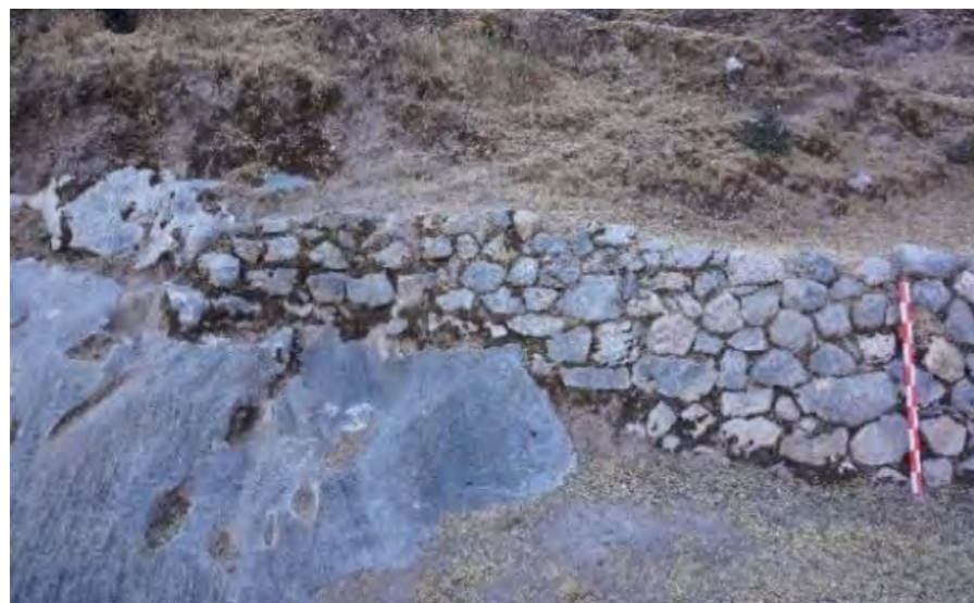
VISTA GENERAL DEL ANDEN ADOSADO EN AFLORAMIENTO ROCOSO
