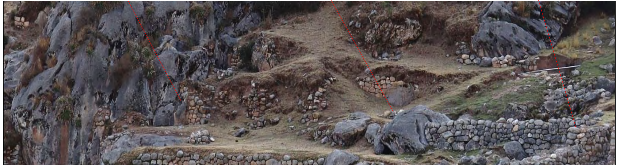
VISTA GENERAL DEL MURO (04)
