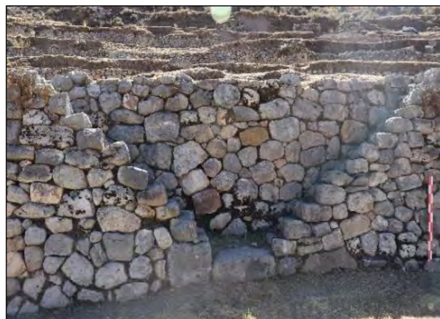
VISTA GENERAL DE LA ESCALINATA EN ANDEN (E-01)
