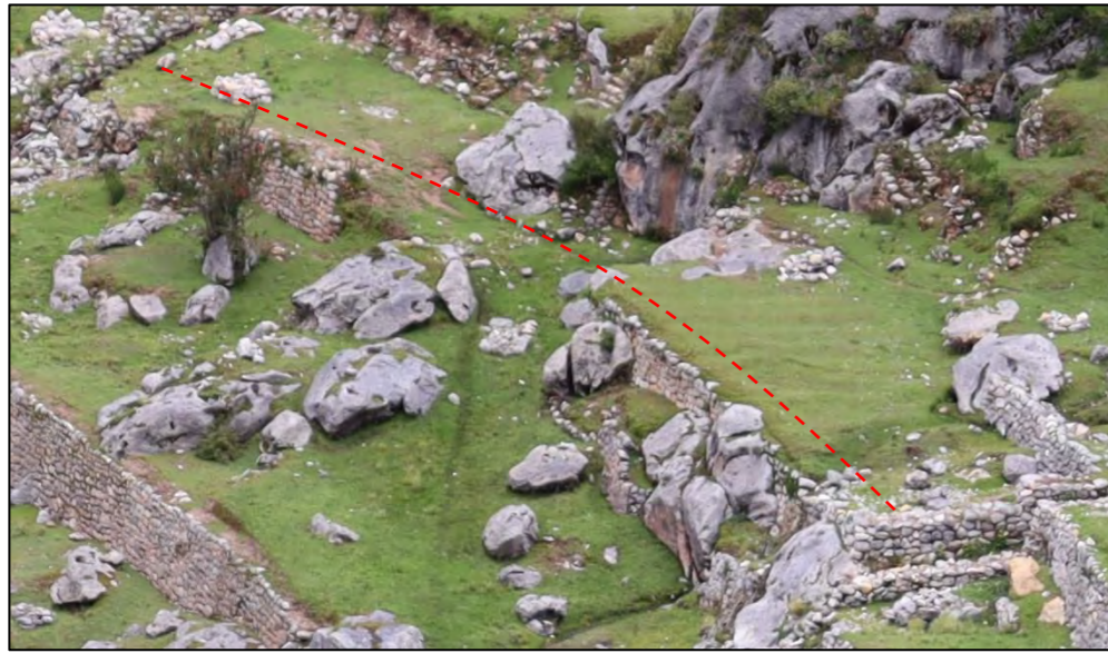
VISTA GENERAL DE LA ESTRUCTURA
