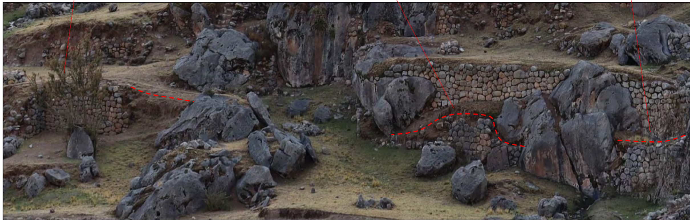
VISTA GENERAL DE LA ESTRUCTURA (MURO 02)
