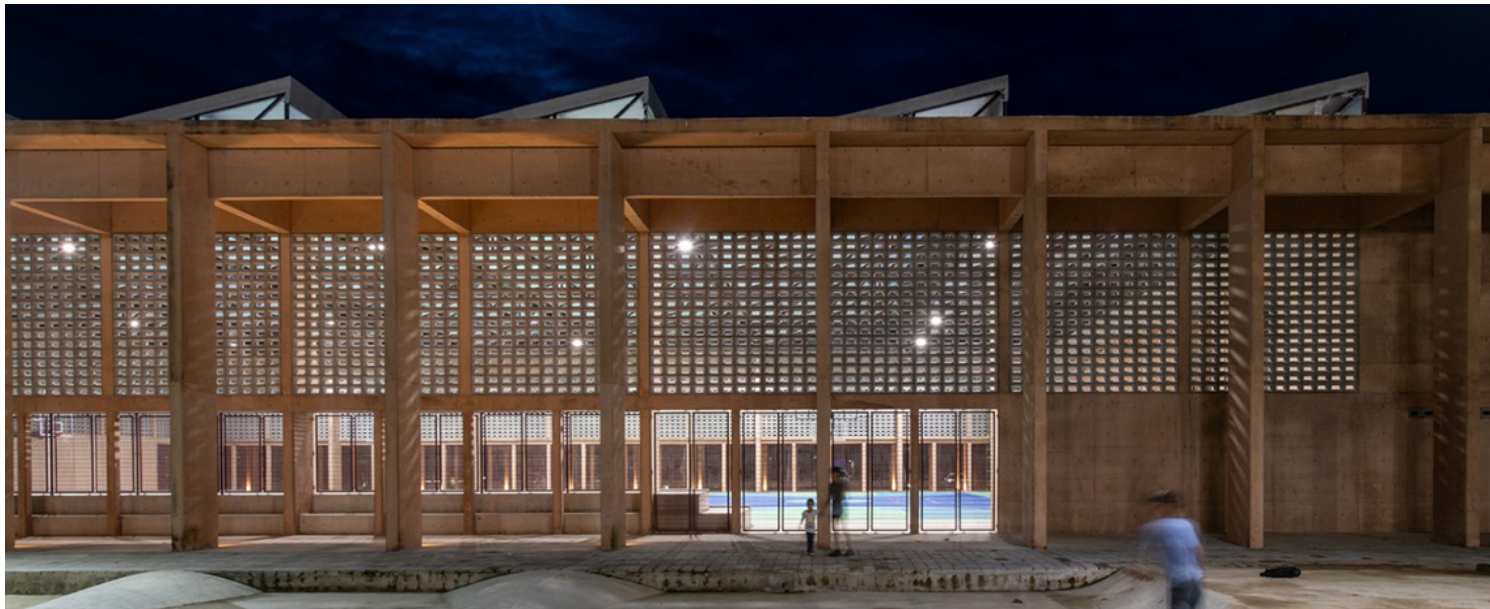
Figura N°76. Vista de fachada polideportivo Nota. Archidaily (2025)
