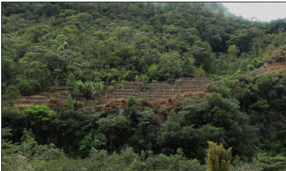
Figura 21. Vista panorámica del sector “A”
