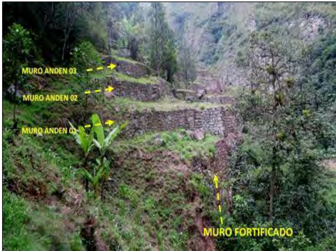
Figura 41. Vista panorámica tomada a las estructuras de la sección 06, nótese el estado de conservación
