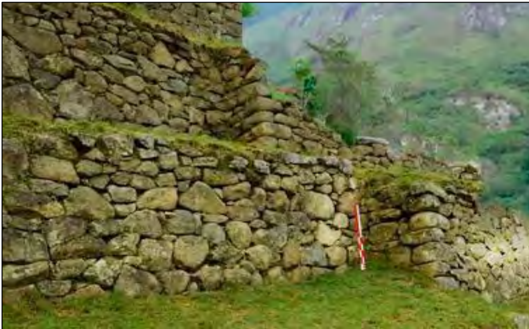
Figura 51. Muro andén 01, subsección 02, sector B
