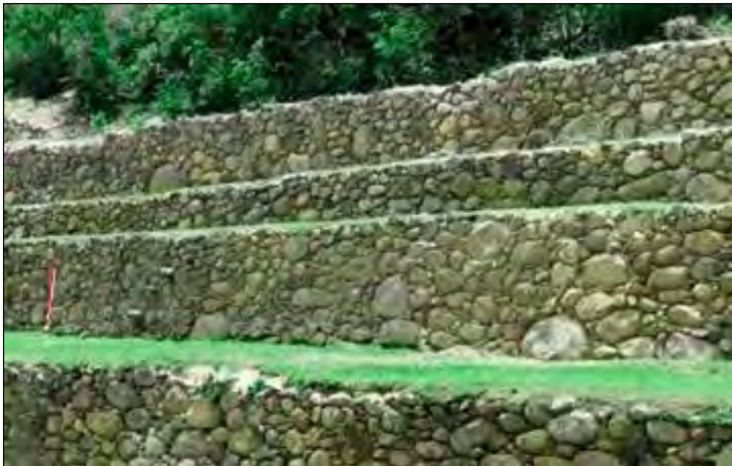
Figura 49. Muro andén 01, subsección 01, sector B
