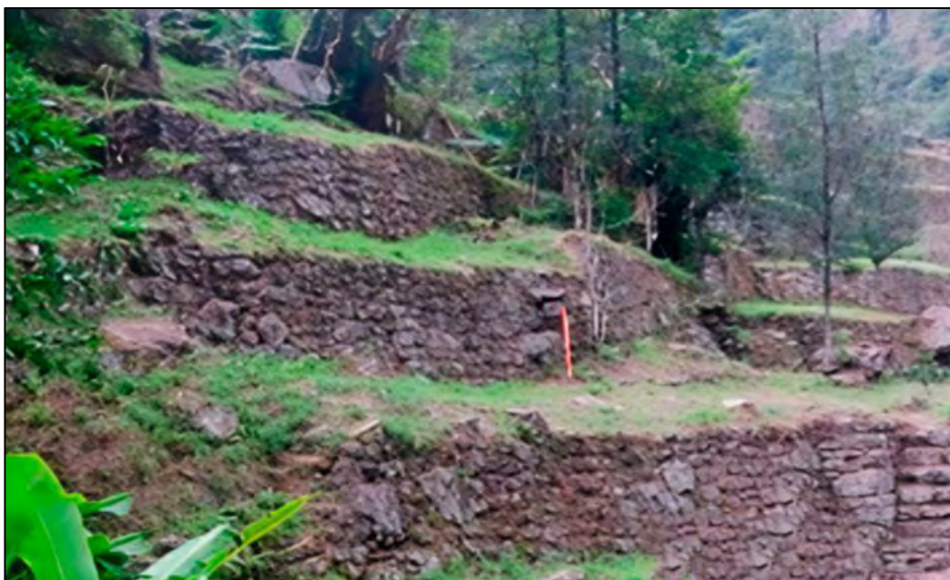
Figura 45. Muro andén 02, subsección 06, sector A
