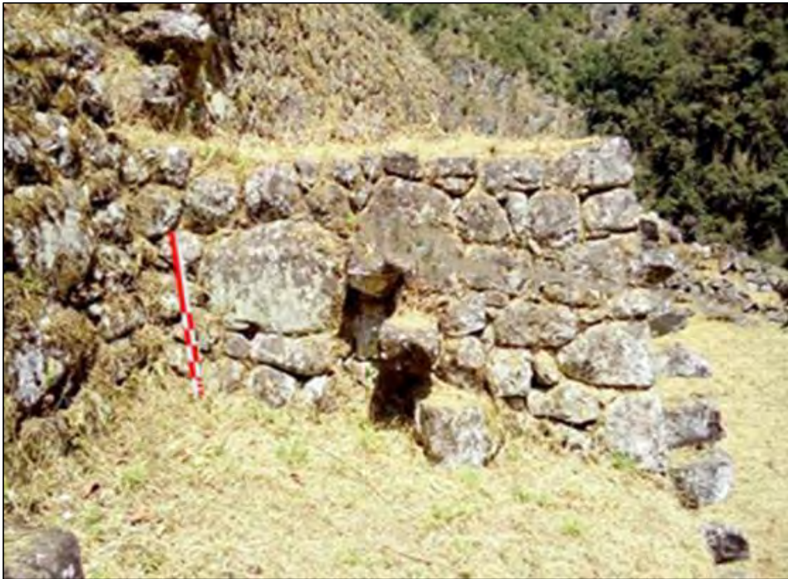
Figura 37. Muro andén 02, subsección 05, sector A
