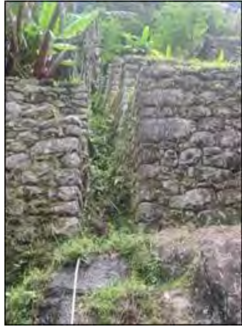
Figura 68. Canal de encauzamiento de agua
