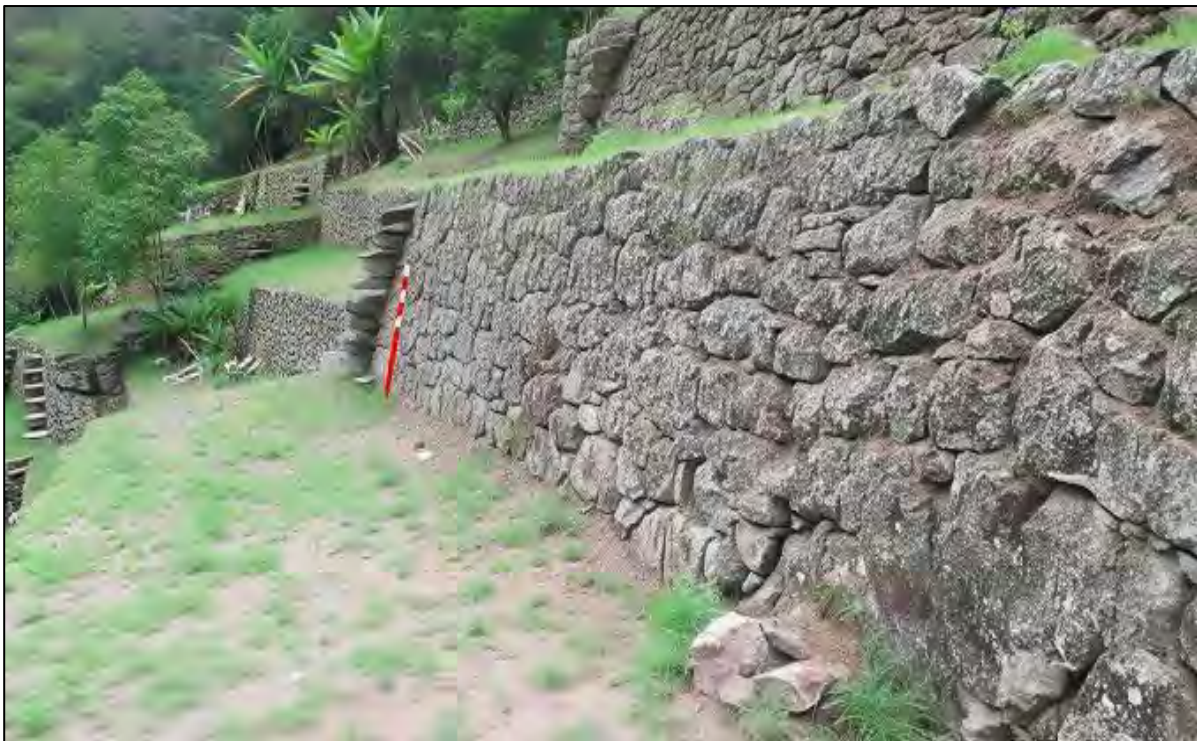
Figura 22. Muro andén 01, subsección 01, sector A
