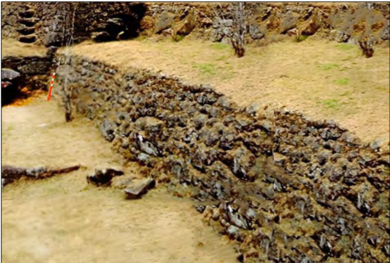
Figura 27. Muro andén 02, subsección 02, sector A
