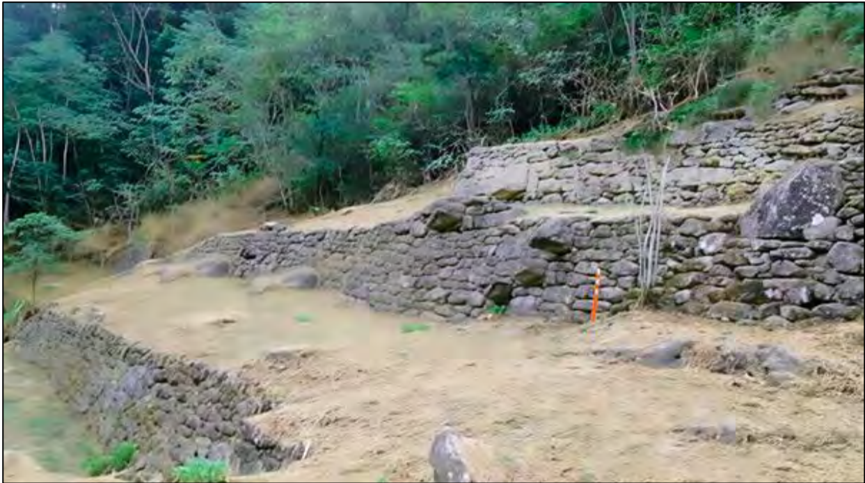
Figura 31. Muro andén 02, subsección 03, sector A
