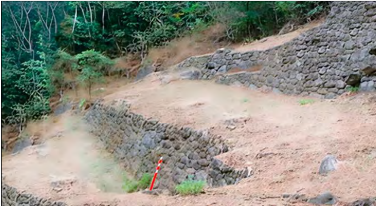
Figura 30. Muro andén 01, subsección 03, sector A
