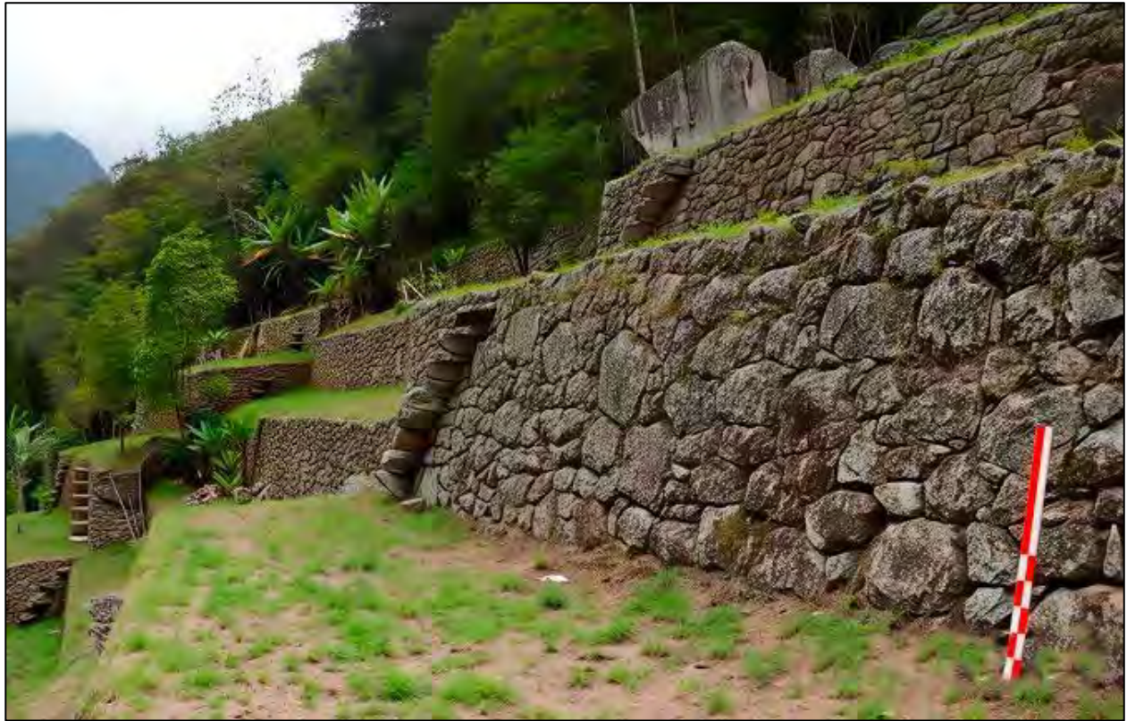
Figura 23. Muro andén 02, subsección 01, sector A
