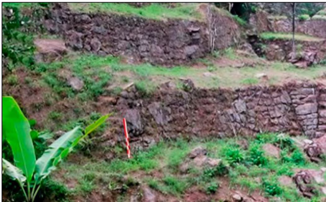
Figura 44. Muro andén 01, subsección 06, sector A
