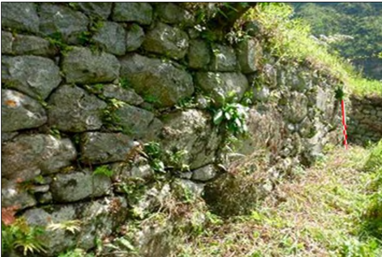
Figura 38. Muro andén 02, subsección 05, sector A
