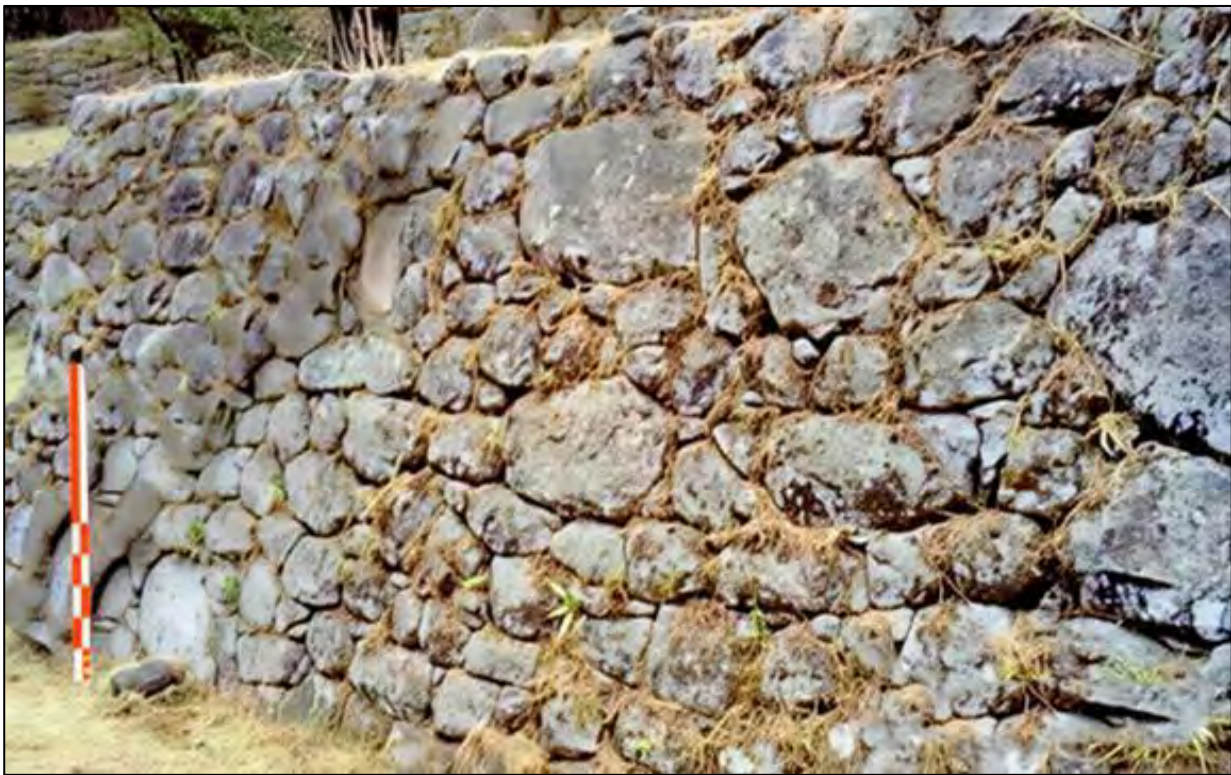
Figura 28. Muro andén 03, subsección 02, sector A
