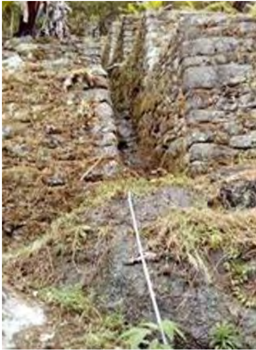
Figura 67. Canal de encauzamiento de agua
