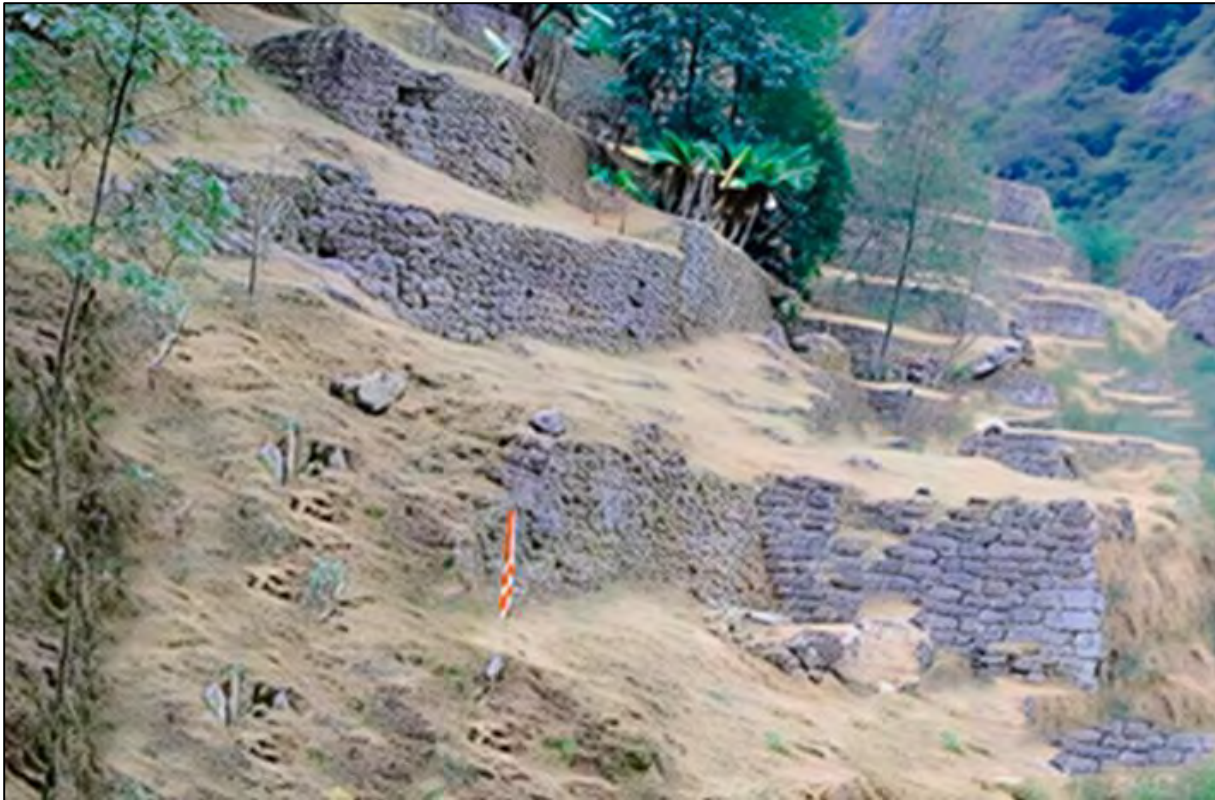
Figura 34. Muro andén 01, subsección 04, sector A
