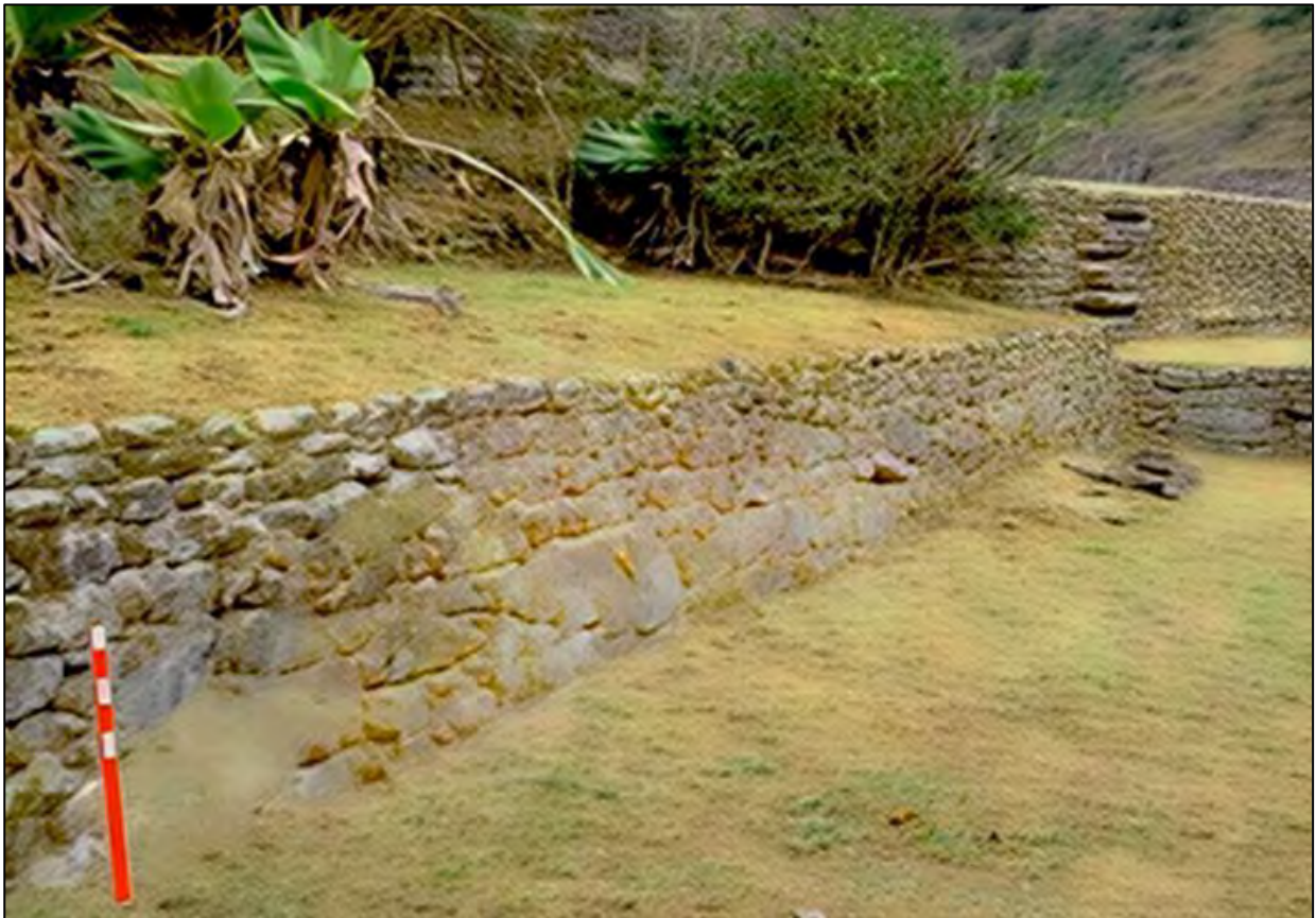
Figura 26. Muro andén 01, subsección 02, sector A
