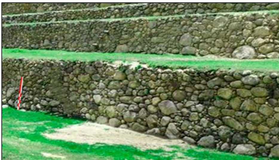
Figura 48. Muro andén 01, subsección 01, sector B
