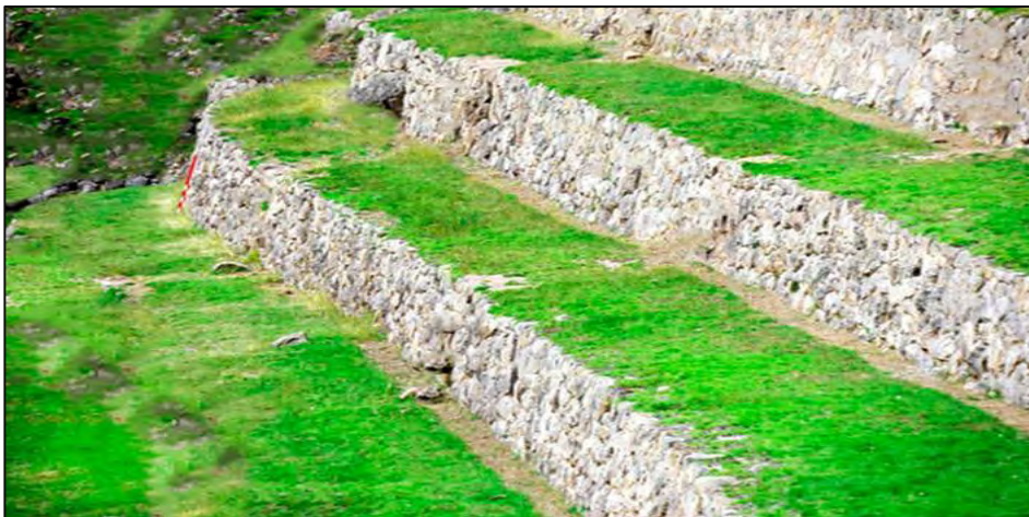
Figura 54. Muro andén 01, subsección 03, sector B
