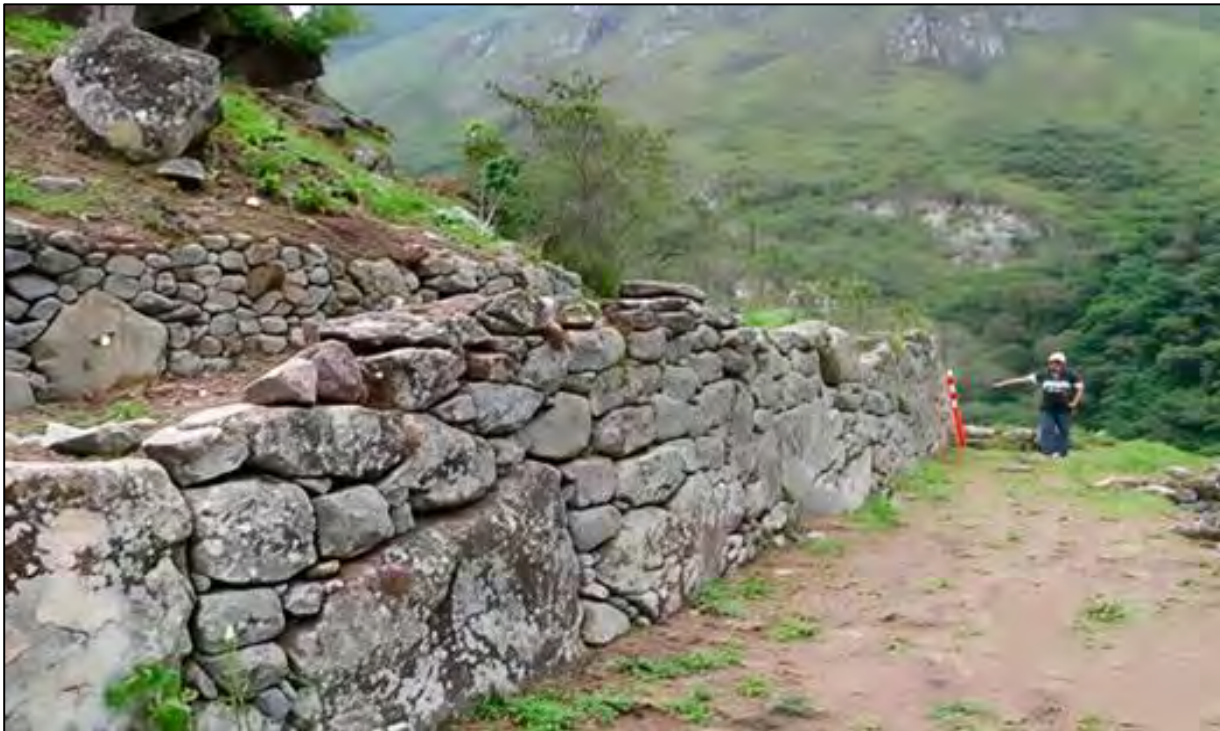
Figura 32. Muro andén 03, subsección 03, sector A
