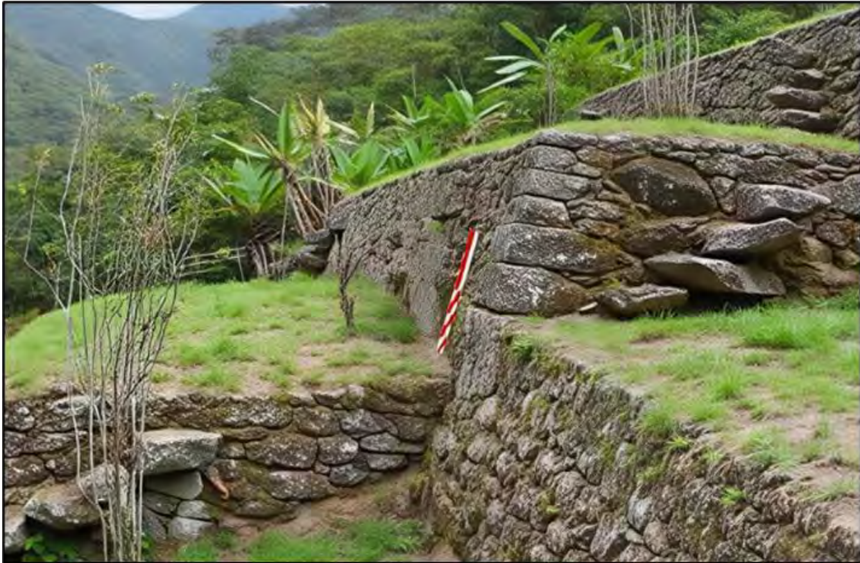
Figura 24. Muro andén 03, subsección 01, sector A
