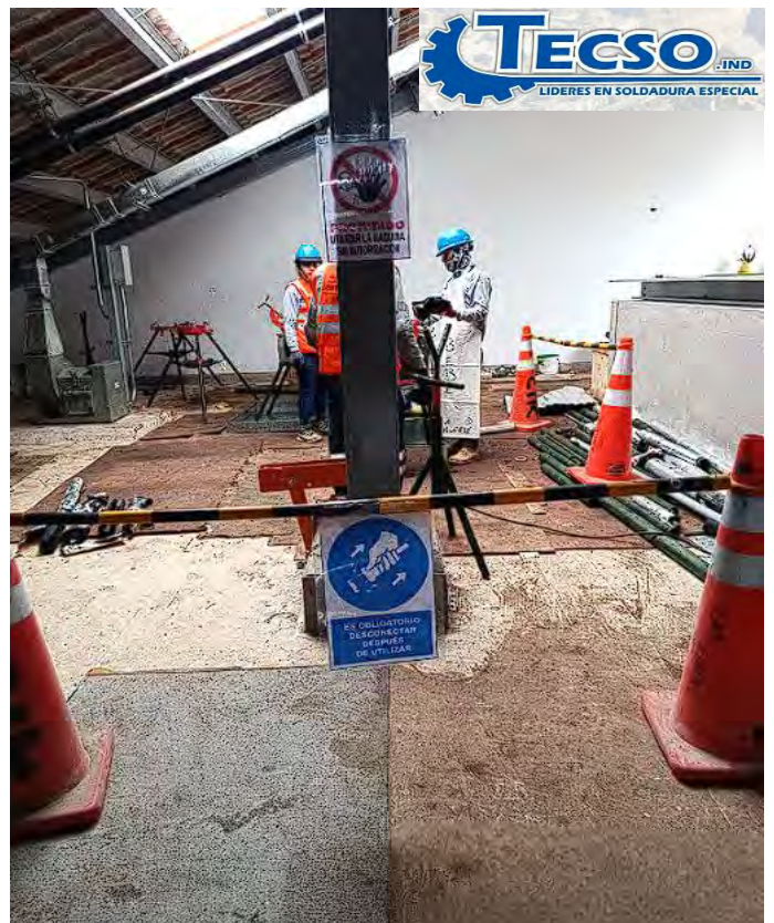
Fotografía 4. Después de implementación de señaléticas
