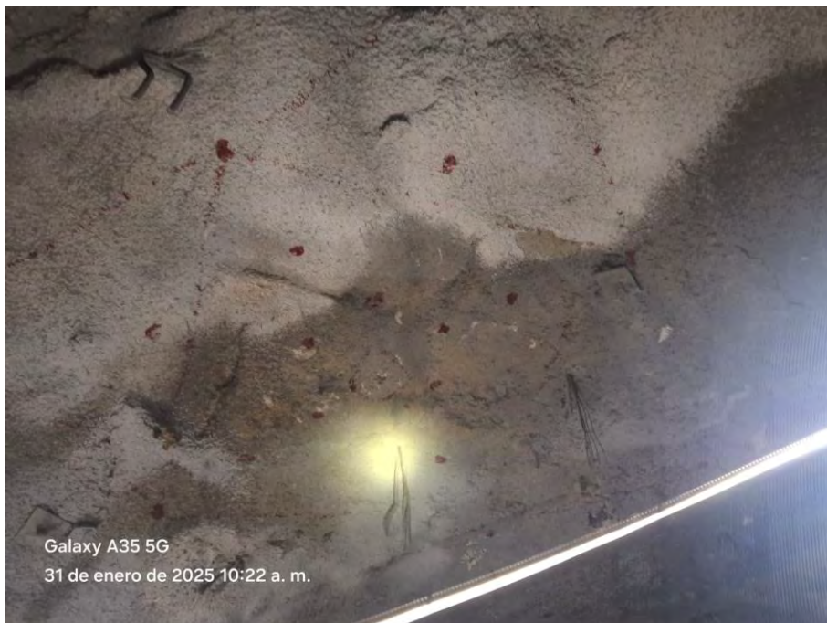
Malla de perforación 3x3 metros para VCR
