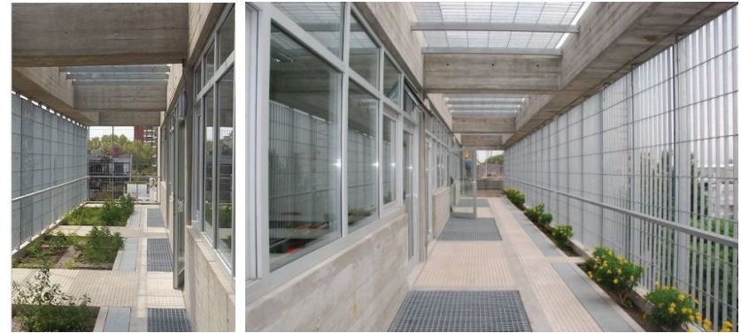
Figura 83. Vistas de los corredores del primer y segundo nivel
