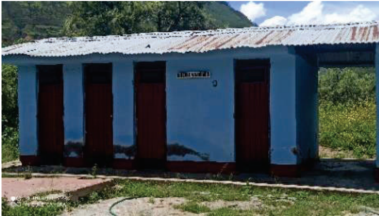
Figura 13. Módulo de servicios higiénicos de varones, damas y duchas.
