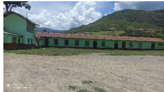
Figura 3. Zona 01 de aulas, talleres, laboratorios y el patio principal Fuente: archivo propio (2021).
