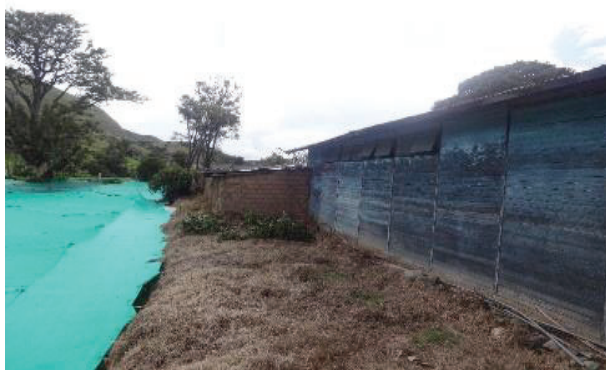
Figura 30. Exterior de la edificación 08 Fuente: archivo propio (2021).
