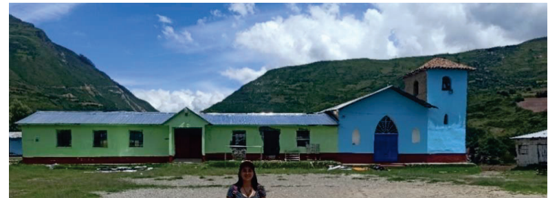
Figura 16. Exterior de la edificación 03
