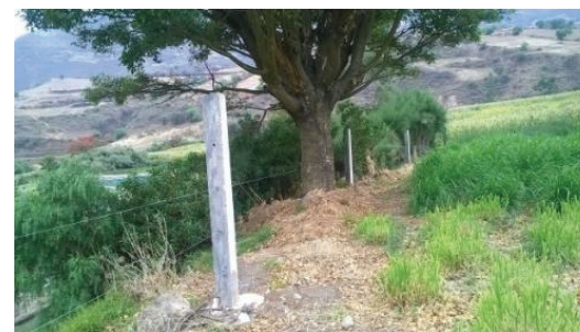
Figura 32. cerco de postes de concreto con alambre. Fuente: archivo propio (2021).
