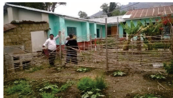
Figura 28. Exterior de la edificación 07
