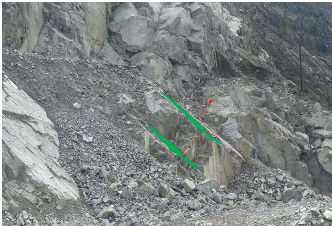
Figura 22. Falla planar, ocurrencia de desprendimiento
