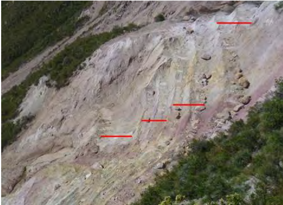
Foto 23. Sistema de banqueo de las plataformas.
