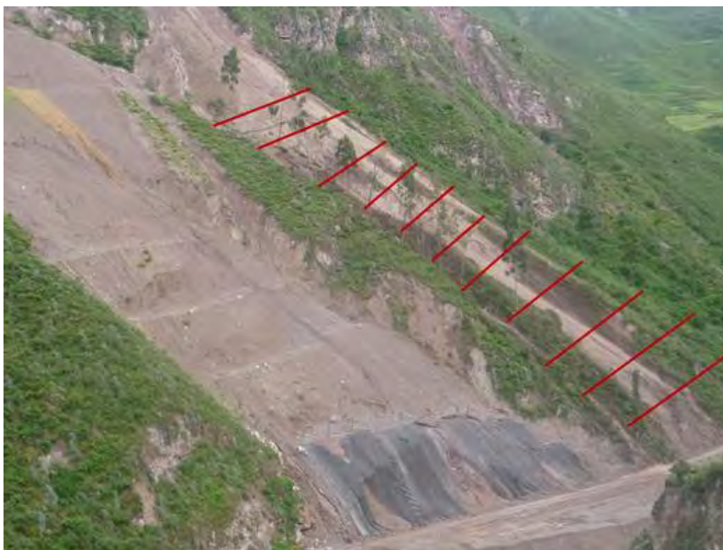
Foto 19. Vista mostrando el banqueo a realizarse.
