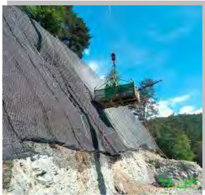
Imagen 18. Colocado de mallas
