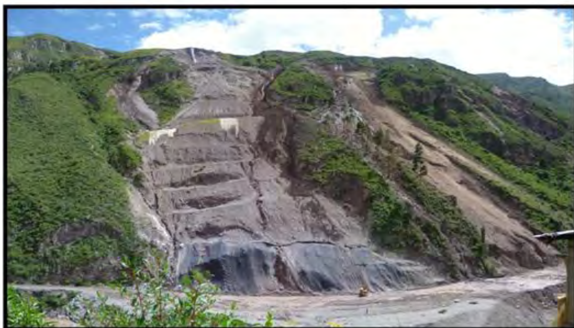
Foto 12. Vista frontal del sistema 2 del conjunto DB5, se observa: tratamiento del deslizamiento con banqueo y geomebranas, en la parte superior e inferior hay la presencia de grietas de hasta 2 cm.
