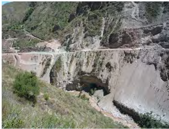
Foto 5. Vista del socavamiento del río y en el lado derecho se observan que la zona es usada como un botadero de materiales.
