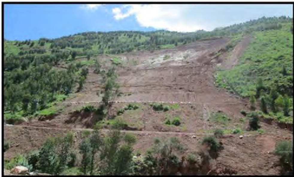
Foto 9. Deslizamiento DB3 en proceso de reactivamiento a pesar de que ya se hizo el tratamiento de estabilidad.
