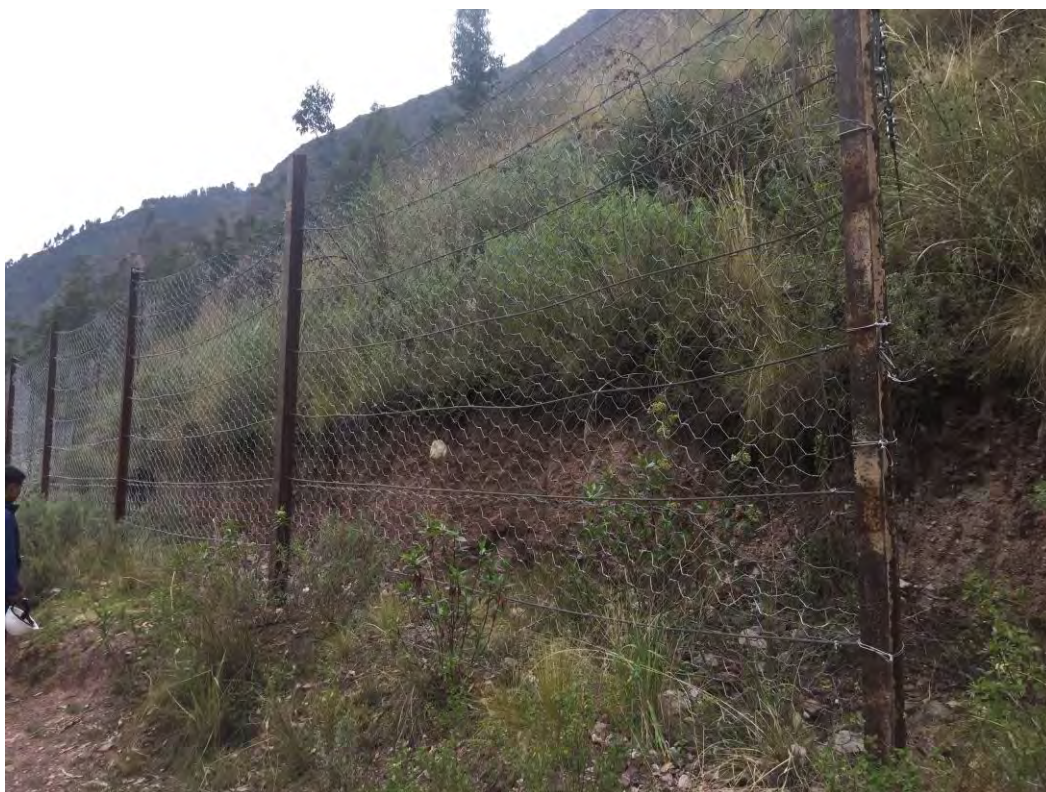
Foto 25. Fotografía que muestra la presencia de vallas que evitan el desprendimiento de bloques.
