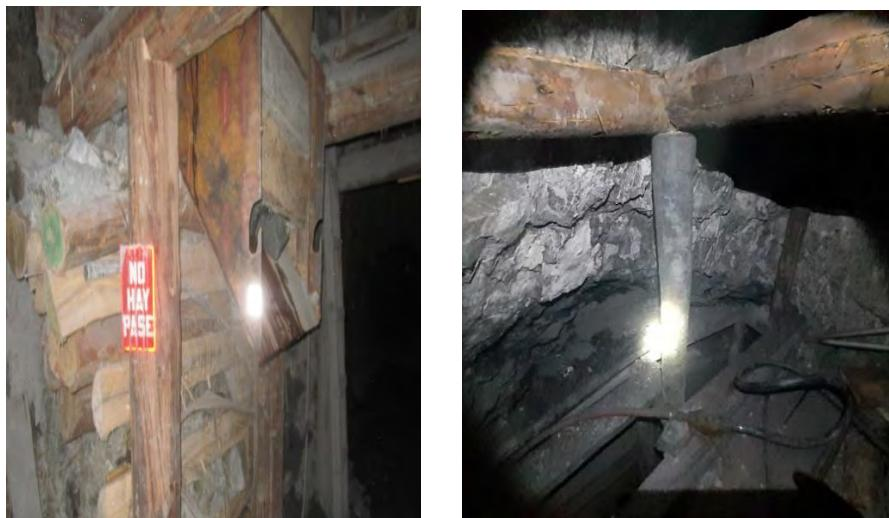
*Nota: En la figura se muestra una tolva coja para el chuteo de mineral o desmonte y el armado de sobre cuadros en los tajos que servirán de camino buzón (Fuente: Operaciones Minas).*
