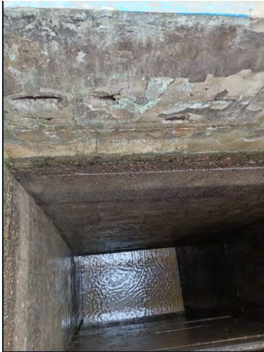
Figura 1 Rotura del cuarto floculador
