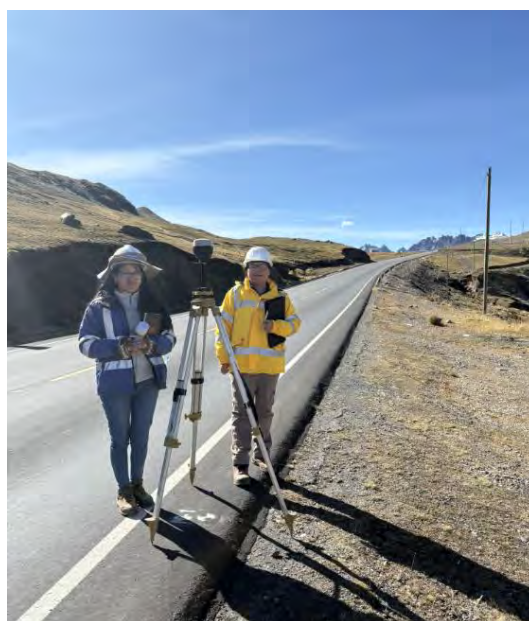
Colocación de puntos de control
