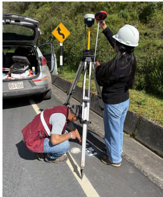
Colocación de puntos de control
