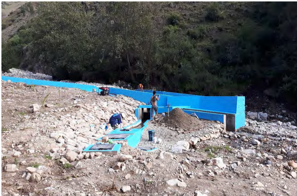
Figura 8: Construcción de la captación del riachuelo Chuyamayo
