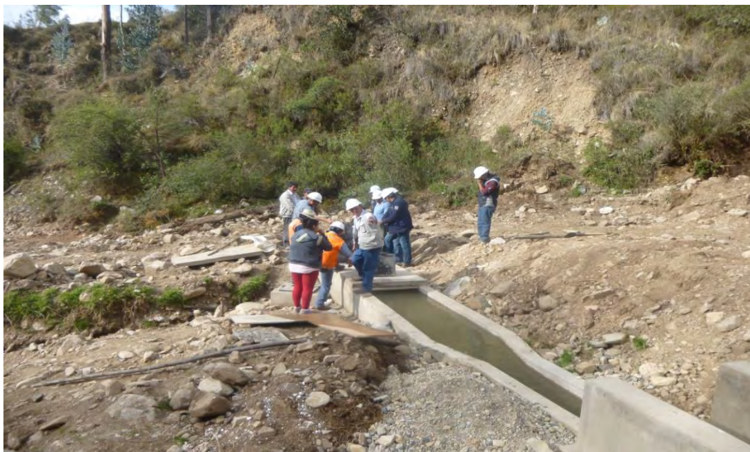
Figura 9: Desarenador a 0+800 km del riachuelo Chuyamayo
