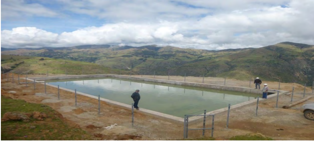
Figura 11: Reservorio de almacenamiento nocturno en el sector de Aijadero
