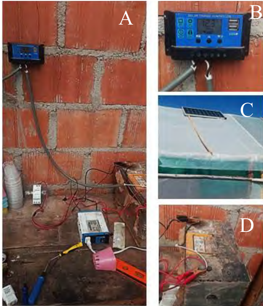
Ilustración 42: Montaje de sistema de alimentación de energía
