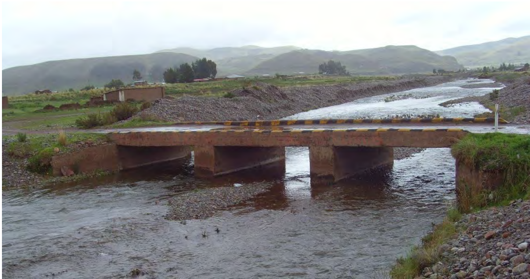
Figura 15: Puente N° 03 (Progresiva 23+885)
