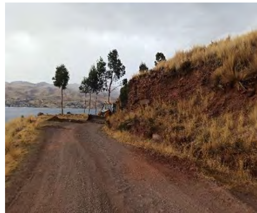
Foto 37. Zona donde se tienen taludes considerables que en la ampliación pueden sufrir derrumbes o deslizamientos Km 10+320-10+380. Foto 38. Zona con taludes empinados que pueden sufrir derrumbe Km 30+270.
