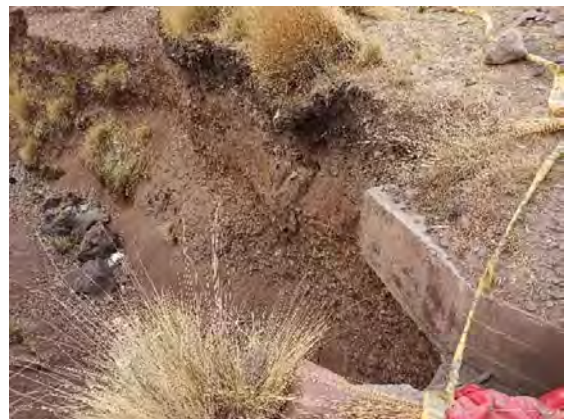
Foto 26. Erosión y carcavamiento en la parta baja de la alcantarilla Km 38+640.
