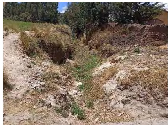
Foto 26. Erosión y carcavamiento en la parta baja de la alcantarilla Km 38+640.
