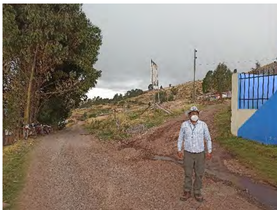
Foto 35. Zona húmeda con bastante filtración de agua en el Km 28+000-29+150.
