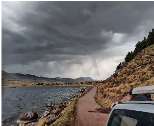
Foto 39. Sector donde se aprecia bloques rocosos sueltos en talud, Km 25+560-25+660.
