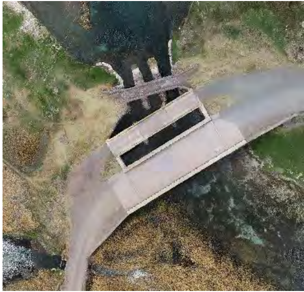
Foto 22: En la vista se observa un puente de la época colonial en la progresiva 3+218.60
