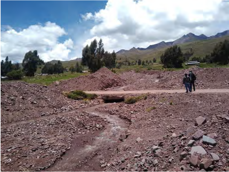
Cuadro 20: Cantera Km 17+020
