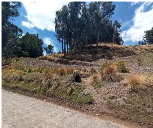
Foto 37. Zona donde se tienen taludes considerables que en la ampliación pueden sufrir derrumbes o deslizamientos Km 10+320-10+380. Foto 38. Zona con taludes empinados que pueden sufrir derrumbe Km 30+270.
