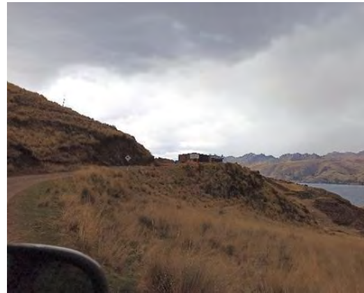
Foto 40. Cortes de talud en roca fracturada Km 30+700.
