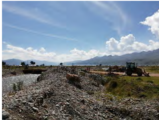
Cuadro 37: Fuentes de Agua: Rio Urinsaya Km 23+855
