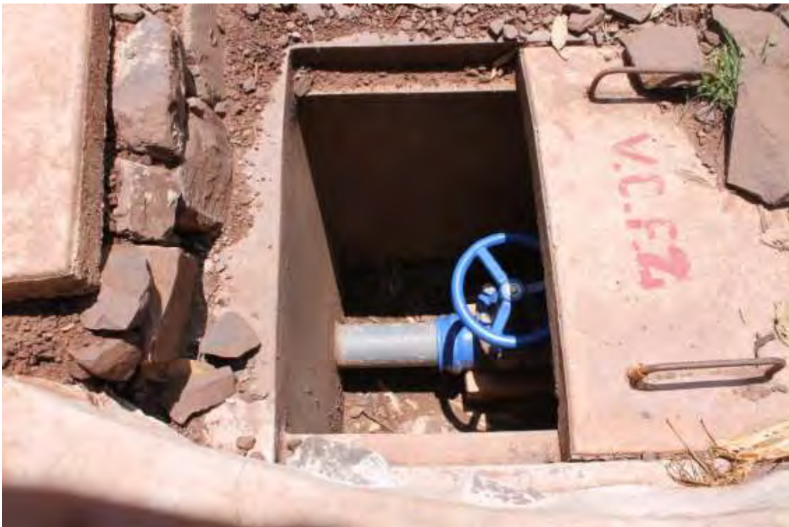
Figura 92. Llave de bocatoma en la comunidad de Ccachabamba, Distrito de Andahuaylillas. Nota. Fotografía tomada por el autor E. Ortega M.
