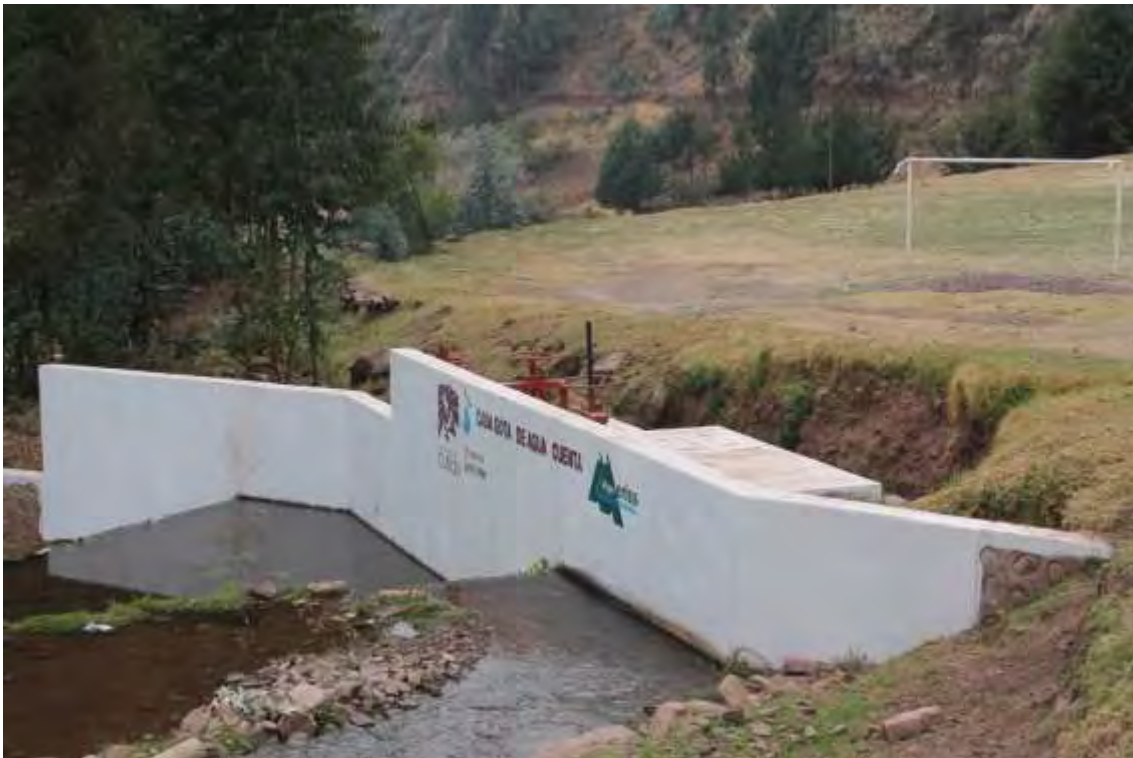
Figura 78. Bocatoma en la comunidad de Ttiomayo establecida por el Plan Meriss. Distrito de Andahuaylillas. Nota. Fotografía tomada por el autor E. Ortega M.
