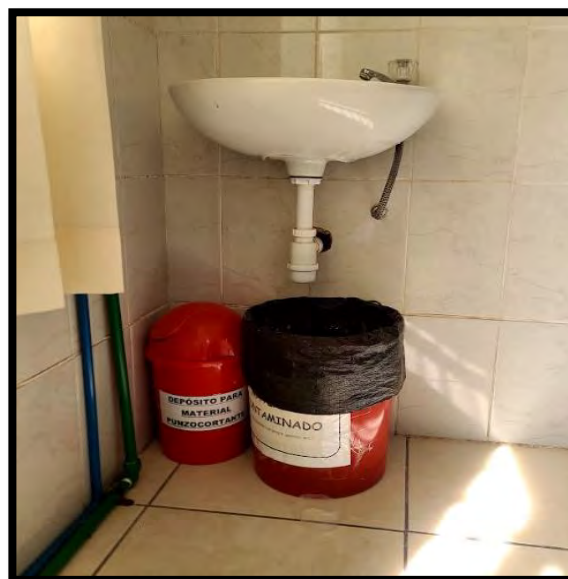
Depósitos de residuos en consultorios
