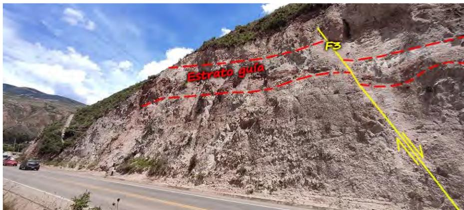
*Fotografía 40. Vista en perfil de la falla inversa local F4*
