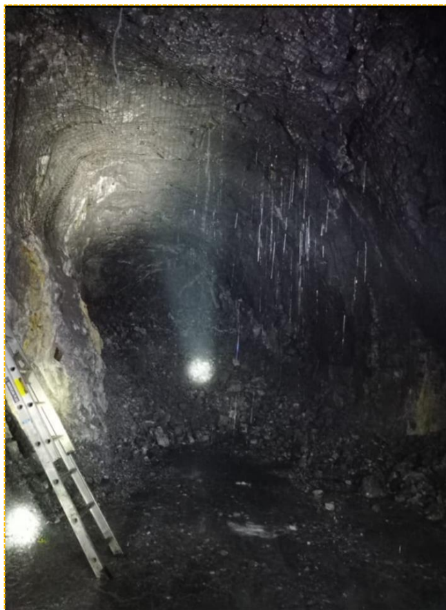
Figura 8: Presencia de agua en las labores subterráneas
