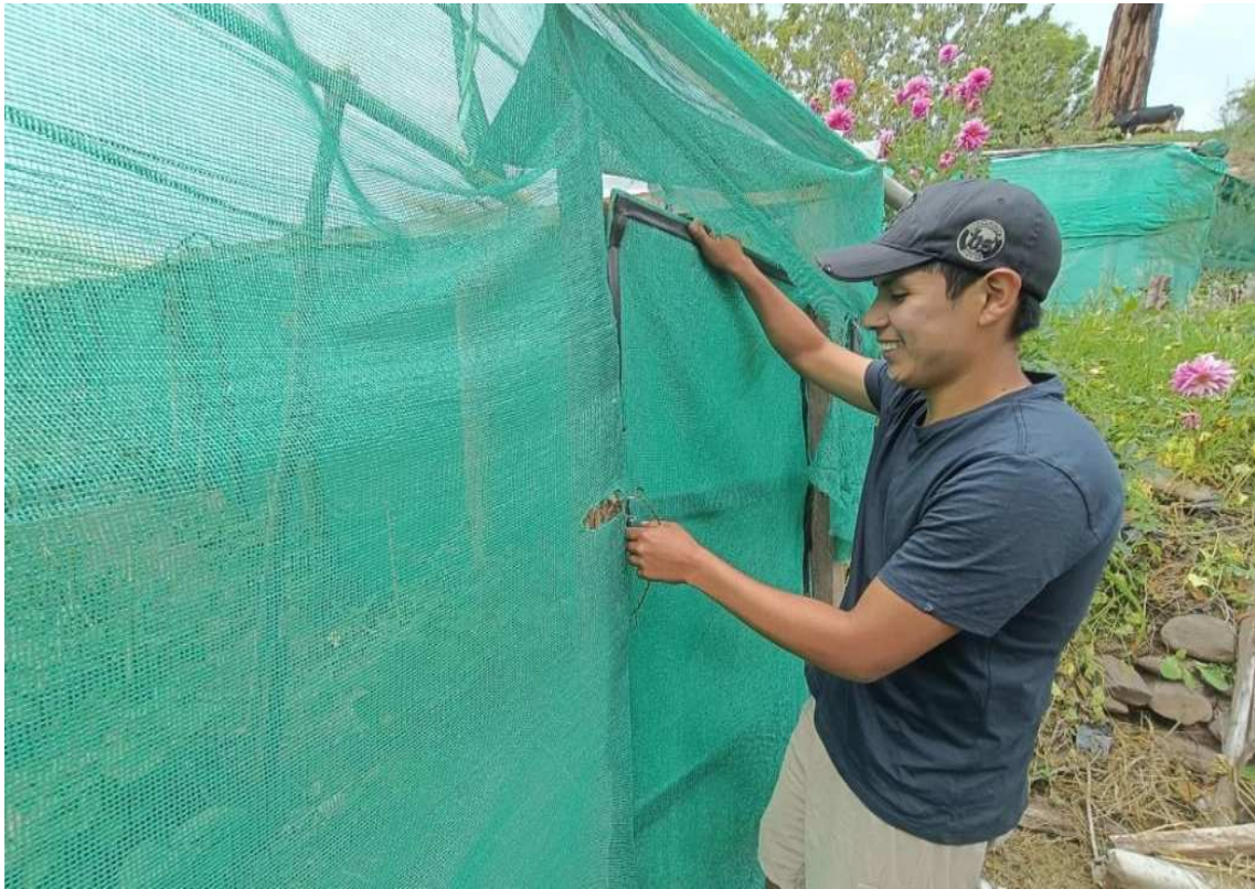
Fotografía N°1: Reparacion del campo experimental
