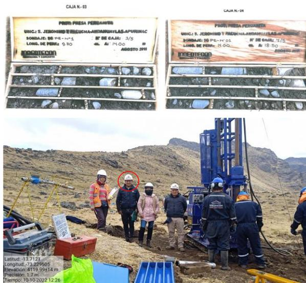
**Nota**, parte superior se observa muestras de recuperación de perforación diamantina. Fuente: Ingeotecom Geotecnia y Concreto. Y en la parte inferior realización de trabajo de perforación diamantina.
