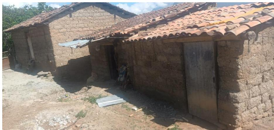
*Nota.* Vivienda rural construida con muros de adobe y techos de teja, en evidente estado de deterioro y sin servicios básicos visibles.
