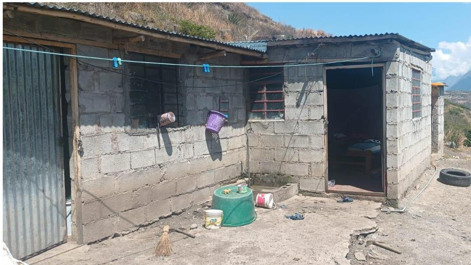
*Nota.* La imagen muestra una vivienda rural precaria, construida con bloques de cemento y materiales reciclados
