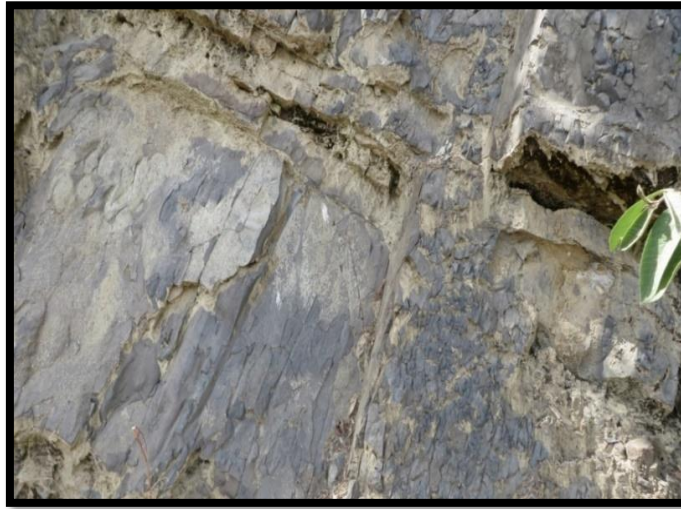
Figura 24: Vista frontal de un afloramiento de roca pizarra alterada por intemperismo (viento, lluvia, sol etc.) en el sector de Cochayoc y Cochayoc bajo, sector de Cochayoc y Cochayoc bajo (E 756102 - N 8603638).
