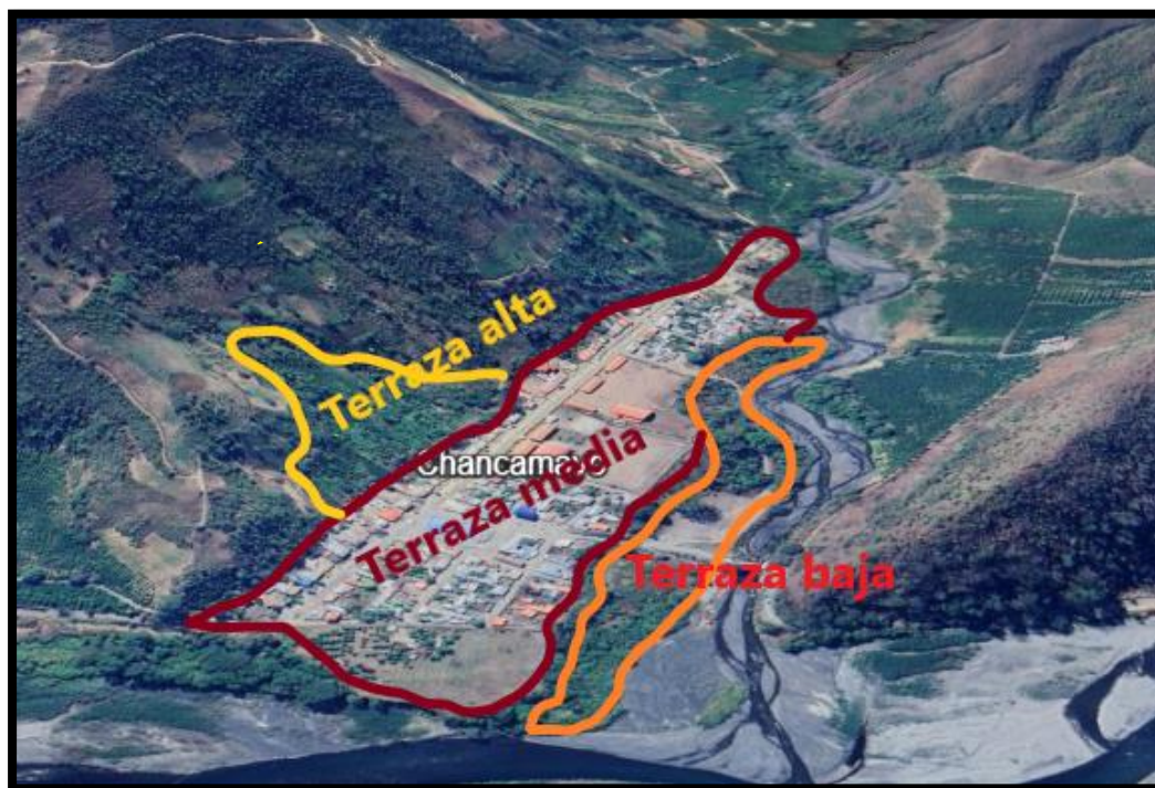
Figura 11: Vista del fondo de valle donde se establece geomorfológicamente el C.P. de Chamcamayo.
