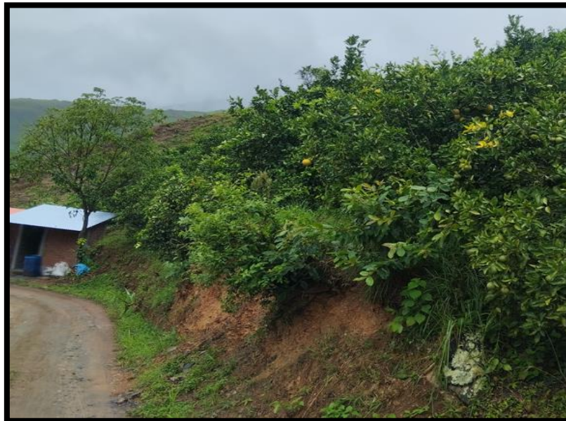
Figura 33: Vista de los depósitos coluviales identificados en corte de carretera del centro poblado de Chamcamayo, con clastos angulosos a sub angulosos relativamente compactados.
