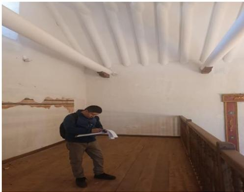
**Fotografía 6:** Evaluación e inspección visual de macroelementos y mecanismos de colapso parte interior Iglesia I.
