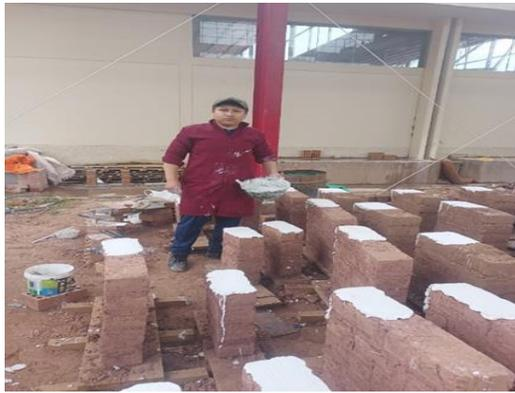
**Fotografía 52:** Colocado de Capping sobre pilas y muretes de mampostería de adobe
