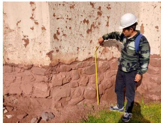
**Fotografía 9:** Medición la altura de sobrecimiento de albañilería de piedra de la iglesia II para elaboración de planos
