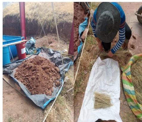
**Fotografía 43:** Preparación de tierra y corte de paja "ccoya" para mezclado posterior.
