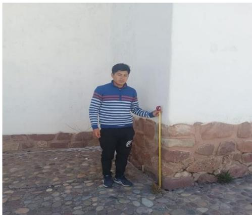
**Fotografía 8:** Medición la altura de sobrecimiento de albañilería de piedra de la iglesia I para elaboración de planos.
