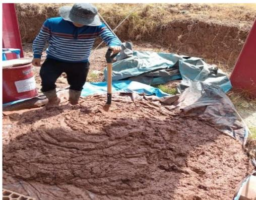
**Fotografía 44:** Preparación de mezcla de tierra y agua.
