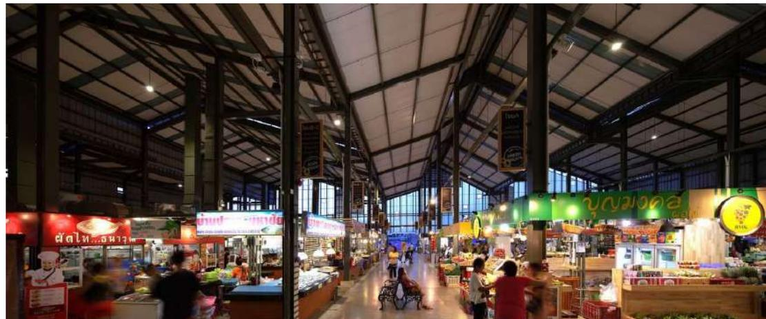
En el diseño de la distribución se enfocó en mantener un orden y zonificación de los productos para su venta. La ventilación del mercado se da entre la división de cada techo de dos aguas, son aberturas que se encuentran en la configuración de la cubierta, en la parte superior del techo.
