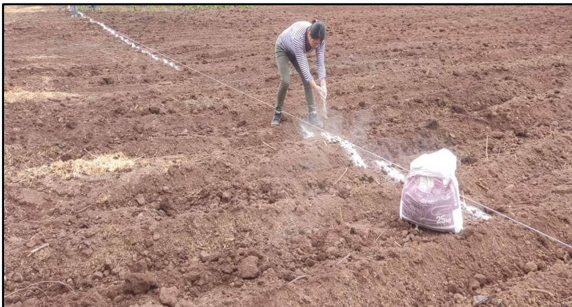
Fotografía N° 2. Trazo nivelación y replanteo
