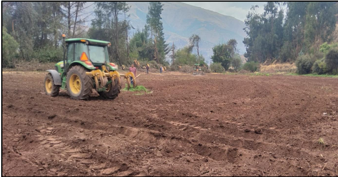
Fotografía N° 1. Preparación del terreno
