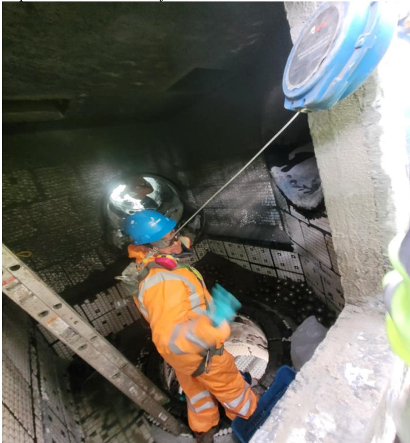
Nota: Elaboración propia. Inspección de presencias de fisuras en los chutes de transferencia los liners de transmisión, técnica ensayos no destructivos, tintes penetrantes y partículas magnéticas. Trabajo de alto riesgo con presencia de espacio confinado y trabajos en altura, ya que el piso grating puede ser retirado en cualquier momento, el inspector requiere de monitoreo de gases y plan de rescate ante una eventual caída a distinto nivel
