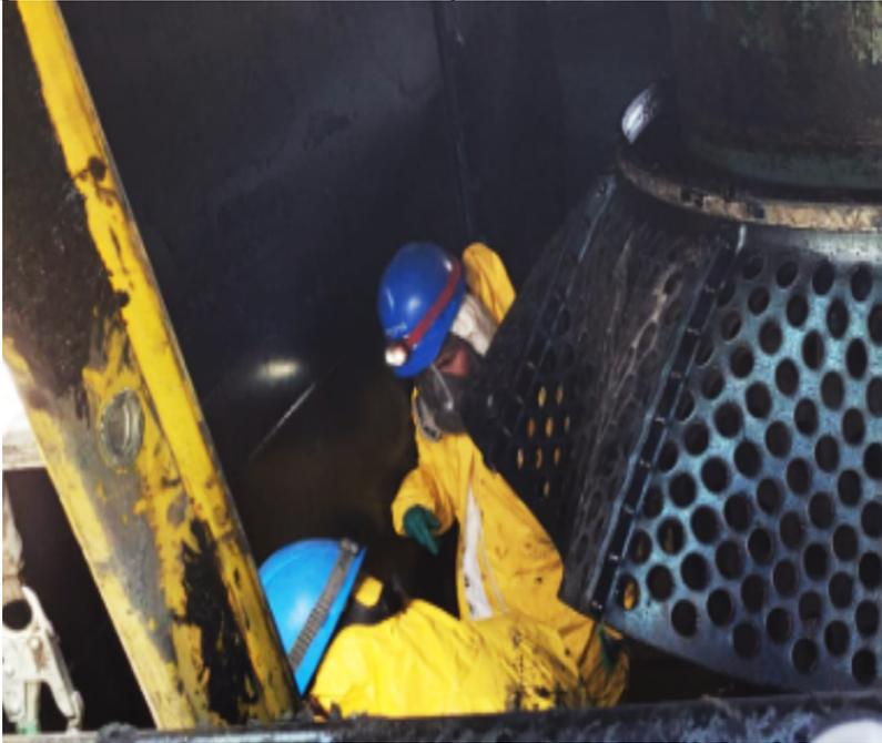
Nota: Elaboración propia. Inspección de espesores internos de la celda de flotación FTR003, técnica ultra sonito UTy ensayos no destructivos tintes penetrantes, inspección ejecutada dentro de las celdas de flotación con presencia de trabajo de alto riesgo, espacio confinado con presencia de gases tóxicos. Se requiere del monitero de gases antes del ingreso del personal a la celda.
