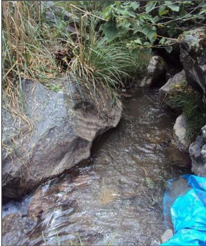
Fotografía 10: Bloques de piedra que forman parte del canal prehispánico lado izquierdo el cual se encuentra erosionado y colapsado.
