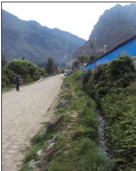
Fotografía 20: Véase el canal hidráulico cubierto por vegetación gramínea y herbácea, el estado de conservación es malo
