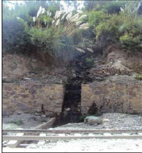
Fotografía 32: Canal de desfogue 04, fue intervenido por la Municipalidad de Ollantaytambo.
