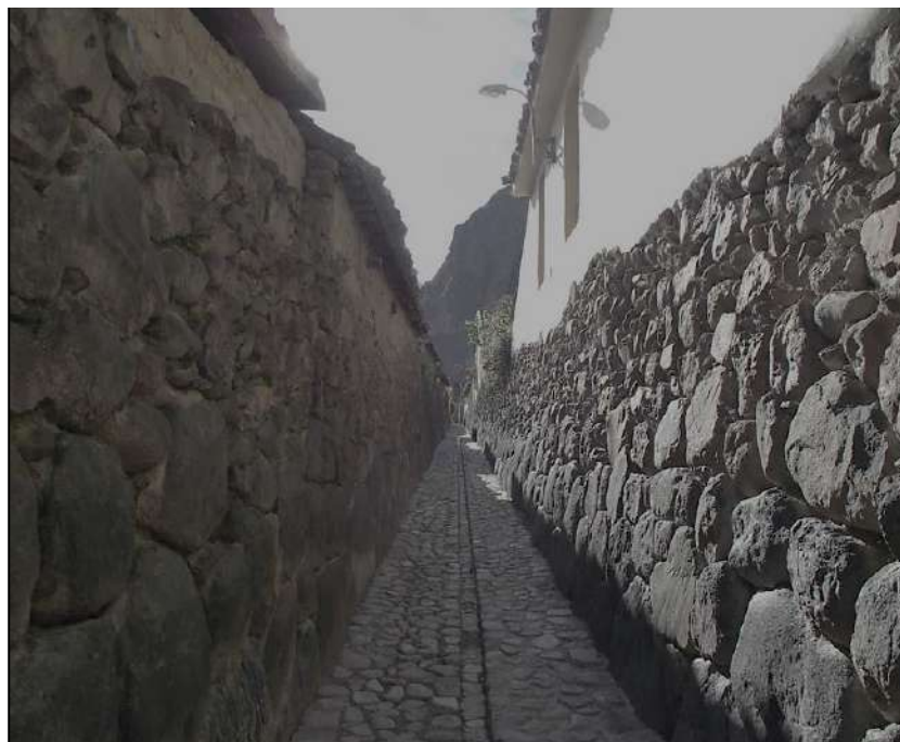
Fotografía 2: Calle transversal Chachacomayoq, ubicada en el sector Qosqo Ayllu.
