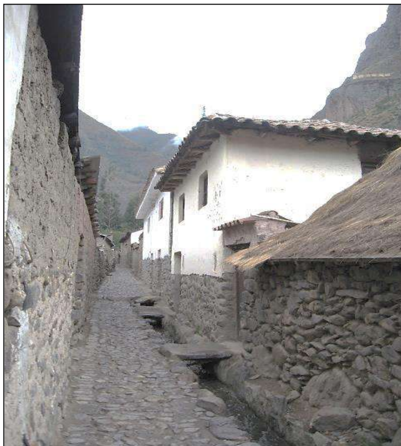
Fotografía 3: Hornocalle ubicada en el Sector Qosqo Ayllu, véase el canal hidráulico.
