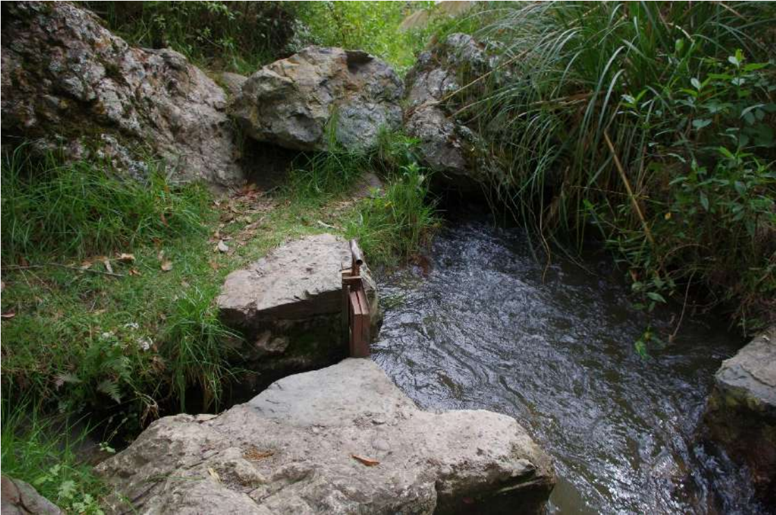
Fotografía 54: Tramos del canal hidráulico en el sector de Qoñaq Huaylla, se ha perdido la evidencia del canal.
