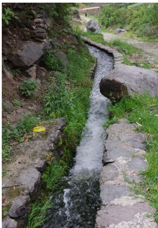
Fotografía 63: Evidencia de tramos originales del canal y restituciones con respecto a la traza y recorrido, se observa que se adecua a la topografía del sector.
