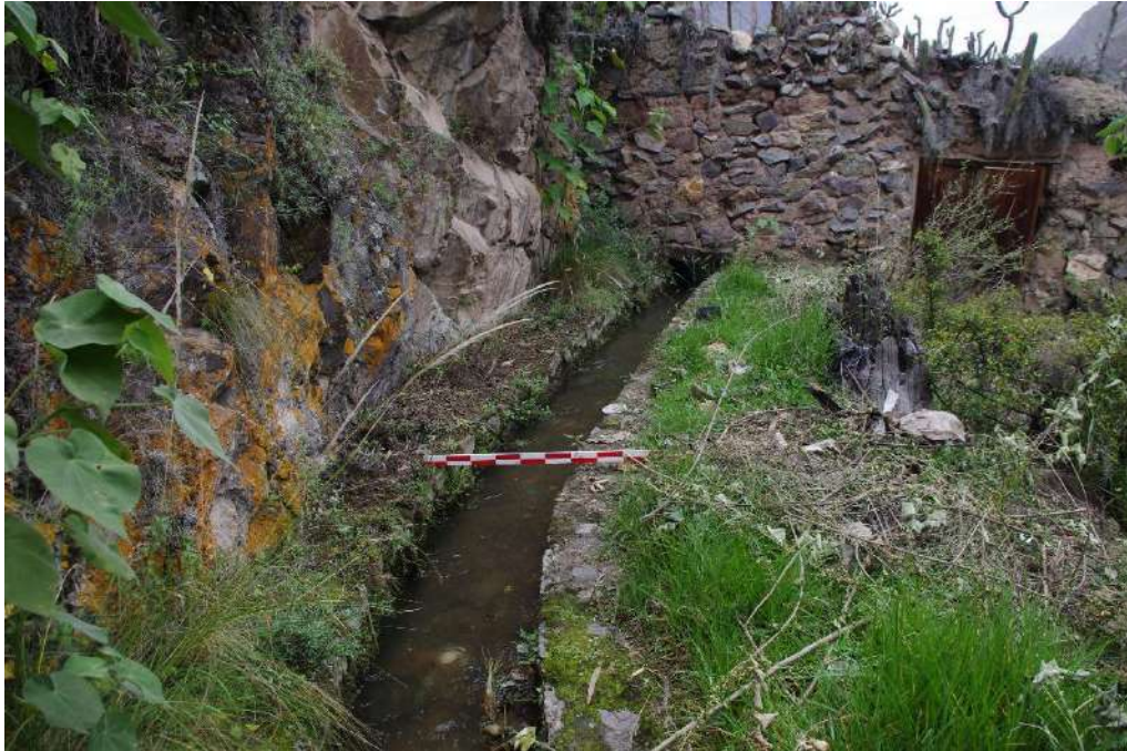
Fotografía 68: Limite del sector Maskabamba, se evidencia continuidad del canal.
