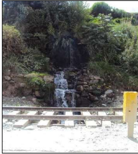
Fotografía 26: Canal de desfogue 01 ubicado en la margen derecha del río Vilcanota.
