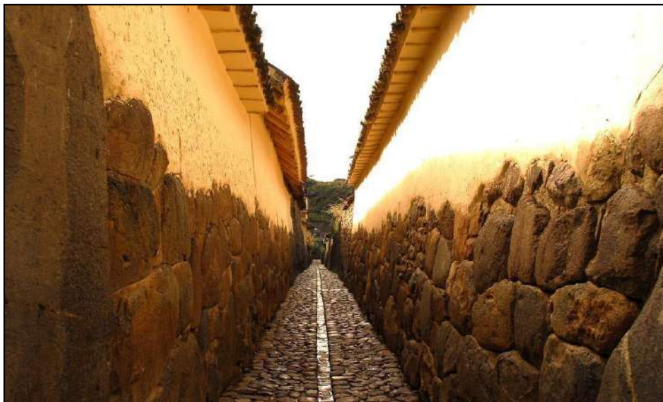
Fotografía 16: Vista panorámica de la calle Chachacomayoq, véase al medio de la calzada el canal o colector de aguas pluviales, en la actualidad se encuentra intervenido.
