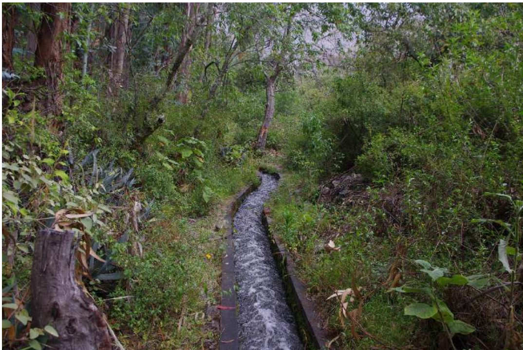
Fotografía 49: Continuidad del canal hidráulico en el sector de Qoñaq Huaylla, este se encuentra acondicionado a la topografía del sector, en este recorrido no se evidencia mayores áreas de cultivo.
