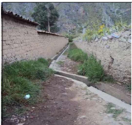
Fotografía 22: Canal hidráulico contemporáneo que fue modificado en su trayectoria, véase el cierre de la vía con cercos de adobe.
