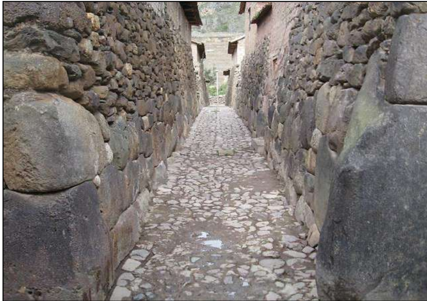
Fotografía 1: Calle transversal Chachacomayoq, ubicada en el sector Qosqo Ayllu
