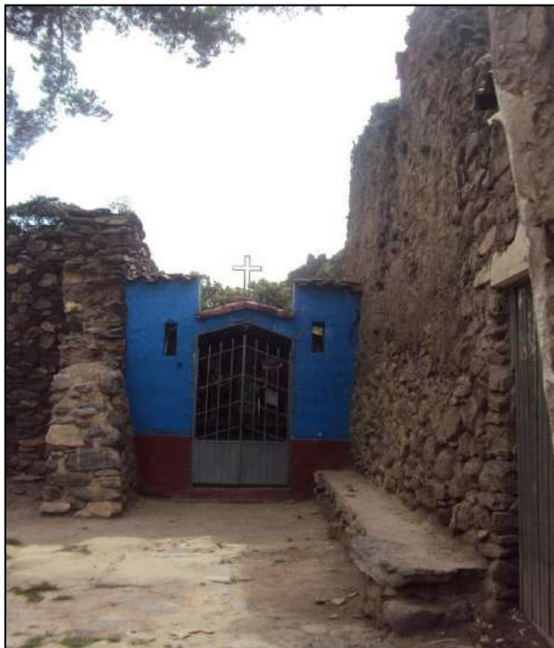
Fotografía 43: 1: Véase, la construcción de la capilla en el acceso principal a Ollantaytambo. Así mismo el grado de inclinación con la que cuenta la estructura del recinto.
