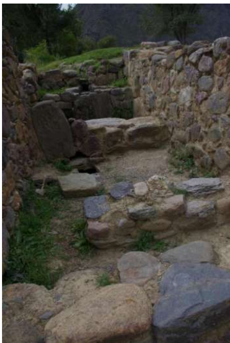
Fotografía 73: Fuente ceremonial en el sector de Q'ellorakay, se evidencia el canal en la cabecera y su continuidad en la base, este continua soterrado y cruza la plaza del sector.
