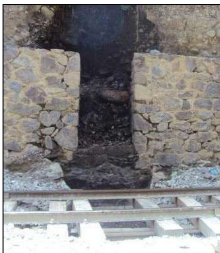
Fotografía 35: Se nota en la restauración que no se tenía certeza de la altura del vano.
