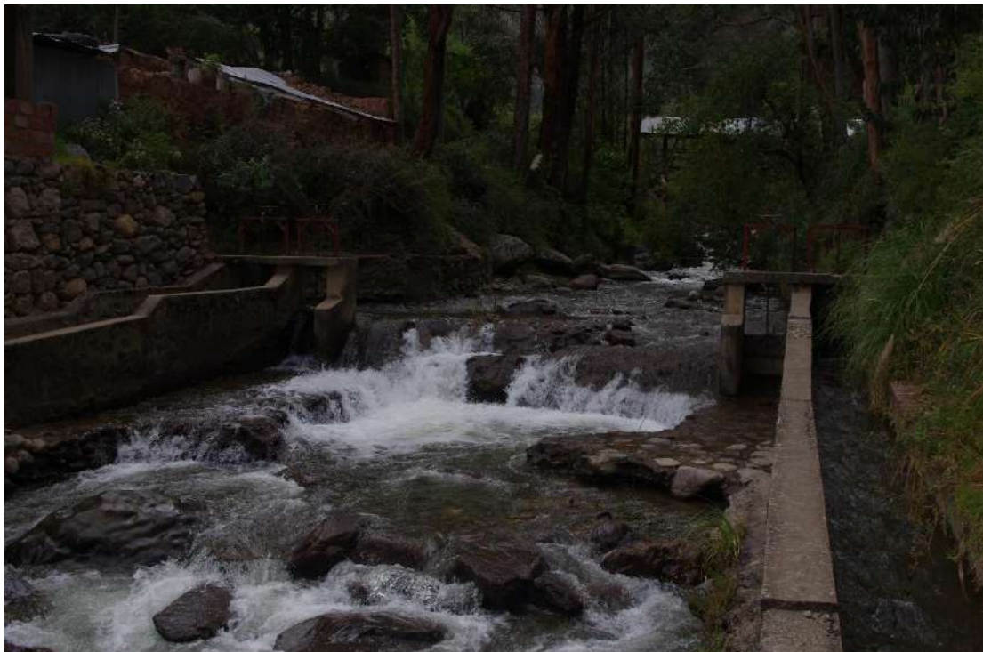
Fotografía 47: Bocatoma, donde se puede evidenciar los dos canales construidos con material nuevo (concreto, el canal derecho es el del sector Qoñaq huaylla..
