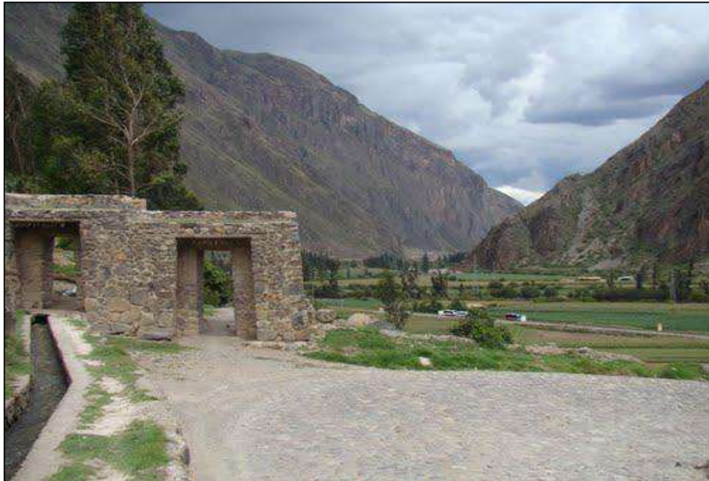
Fotografía 45: Véase el canal restaurado con material nuevo (cemento, arena).
