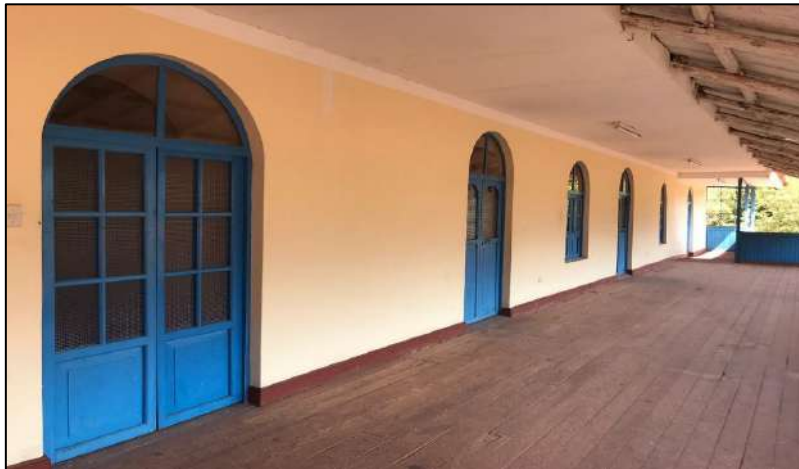
Fotografía del corredor del claustro
