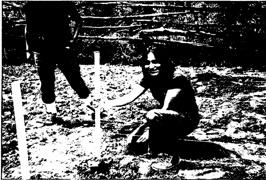
Fotografía 3: Replanteo y parcelado del terreno
