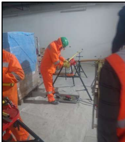
Figura 68: preparación de tubería y roscado con tarraja manual
