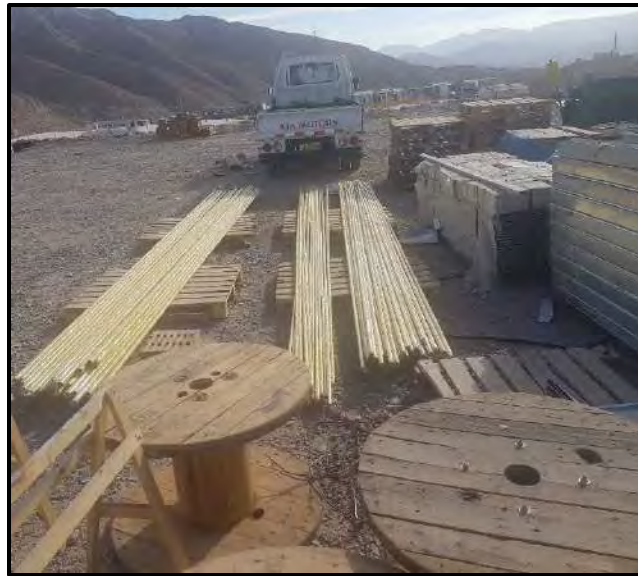
Figura 67: preparación de tubería y roscado con tarraja manual
