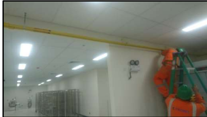
Figura 78: vista, soporte para tubería
