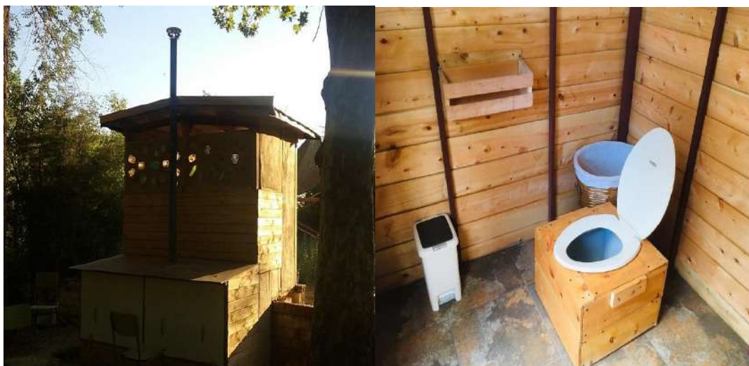
Figura 119. Servicios higiénicos adecuados
