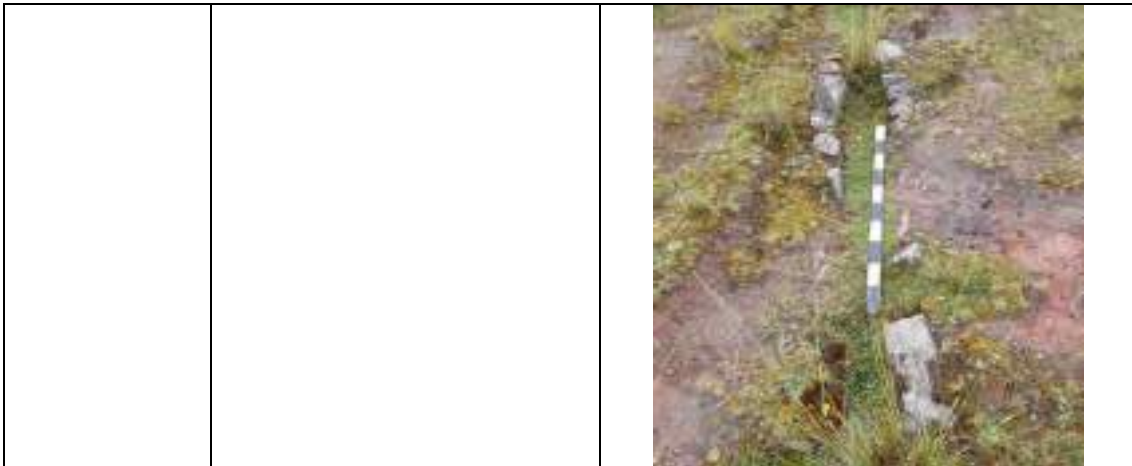
Cuadro 12: Disipador de agua
