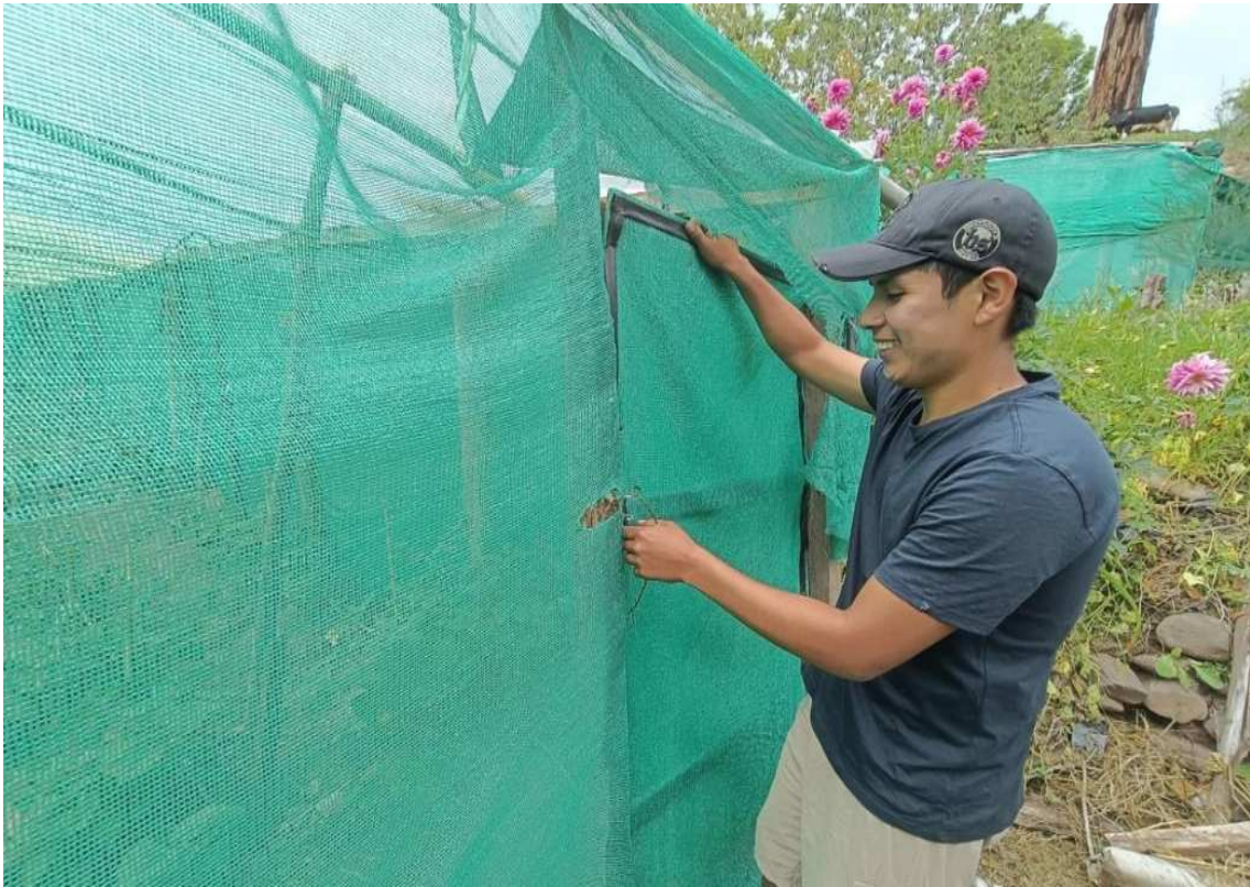
Fotografía N°1: Reparacion del campo experimental
