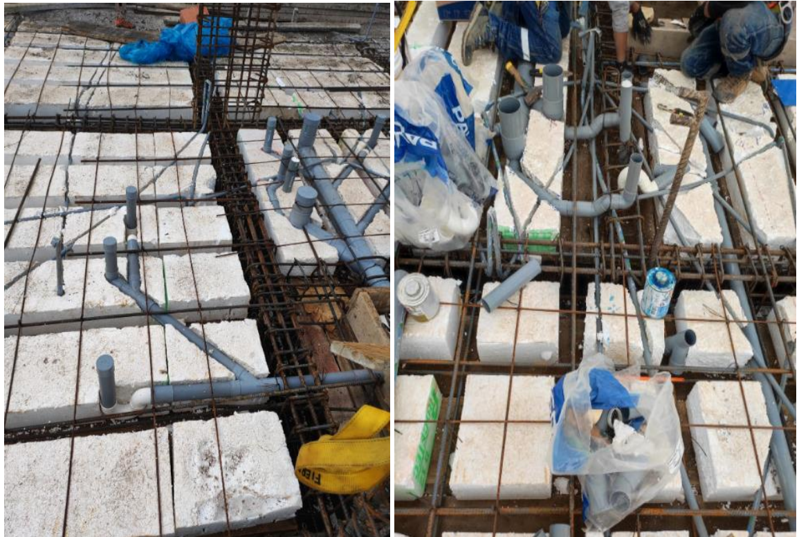
Figura 35 Refuerzo en vigas
