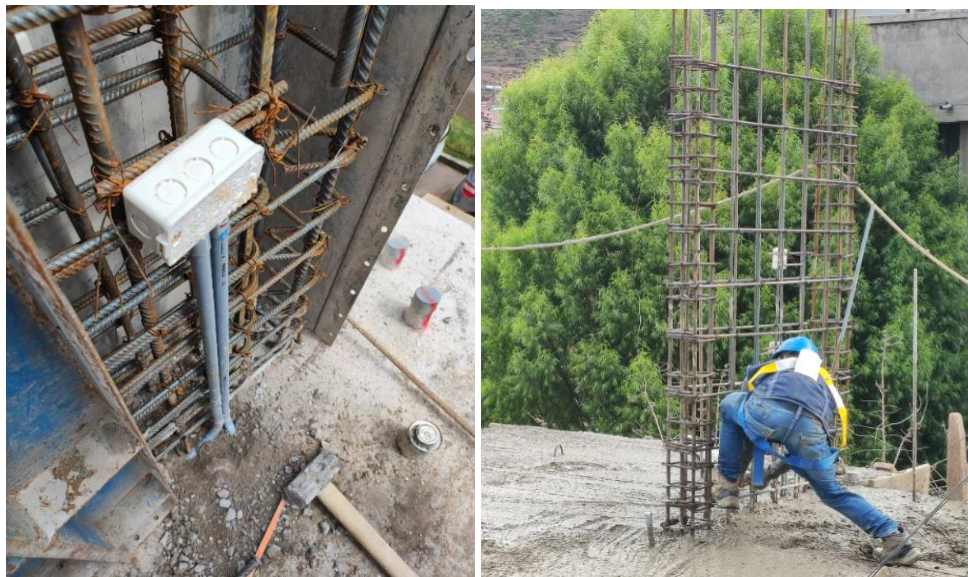
Figura 43 Colocación de puntos de Tomacorrientes en columnas y placas
