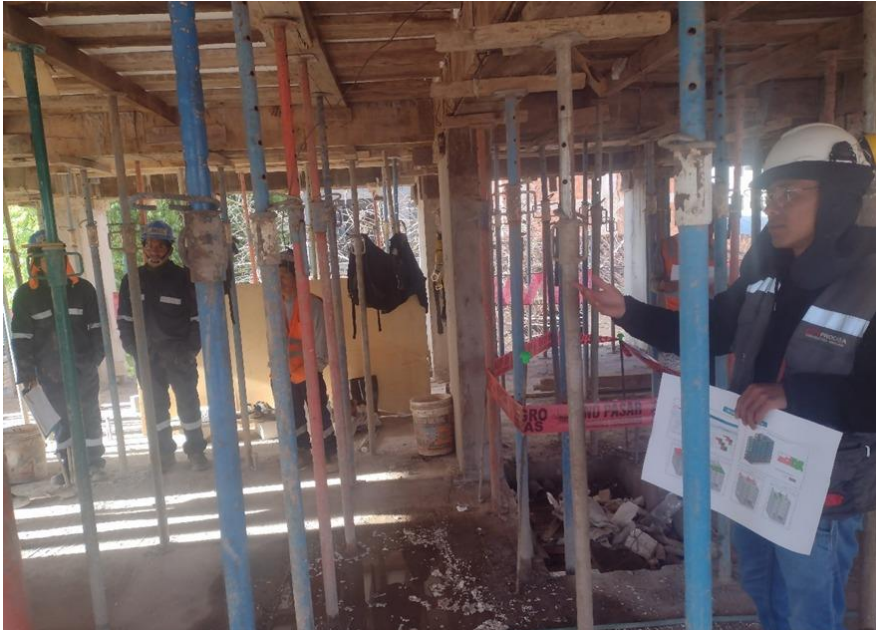
Figura 94 Charla diaria en obra con el personal obrero
