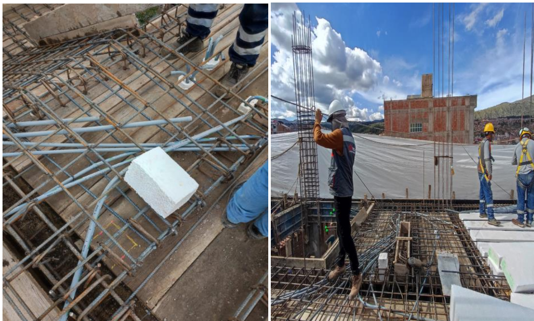
Figura 39 Pases para paso de tuberías ACI
