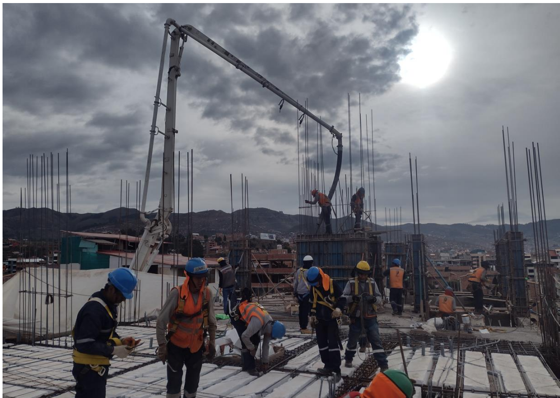
Figura 56 Vaciado de concreto f'c = 245 \text{ kg/cm}^2 verticales S1 del 6to nivel
