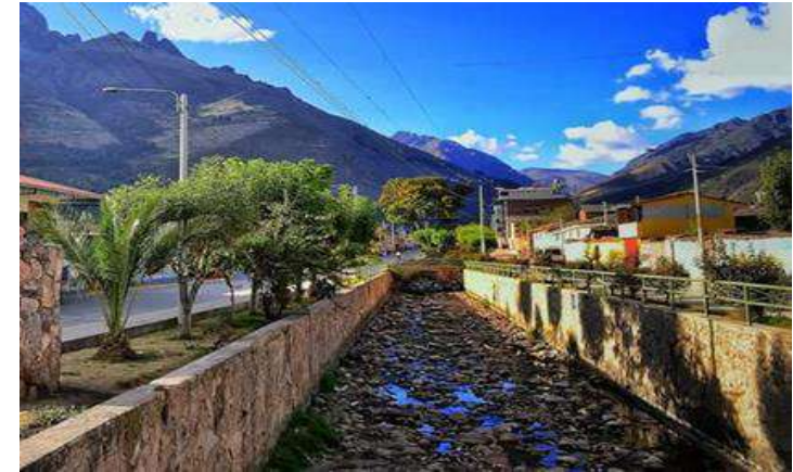
Figura 48 Vista de la calle Ucayali
