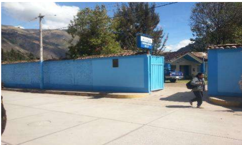
Figura 64 Vista de local de Essalud
