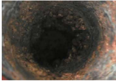
Foto N° 3 vista Superior (Foto en copio)
