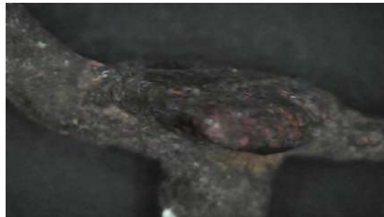
Foto N° 3 vista lateral izquierda (Foto copio)
