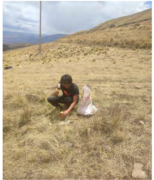
Figura 43 Estacado del eje de la carretera
