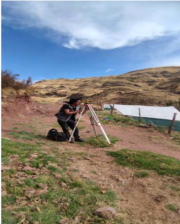
Figura 42 Nivelación del eje de la carretera
