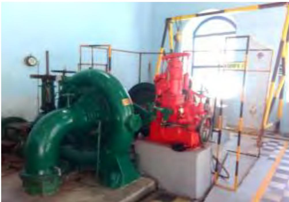
**Figura 4.7** Unidad generadora II (turbina).
