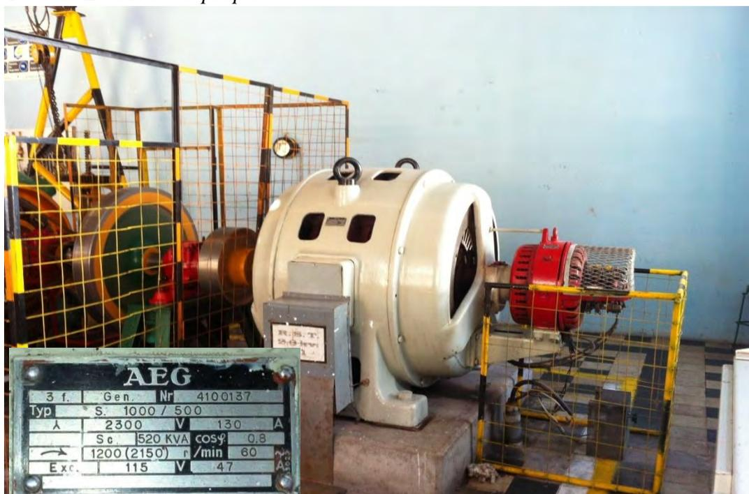
**Figura 4.8** Unidad generadora II (generador y placa da valores).
