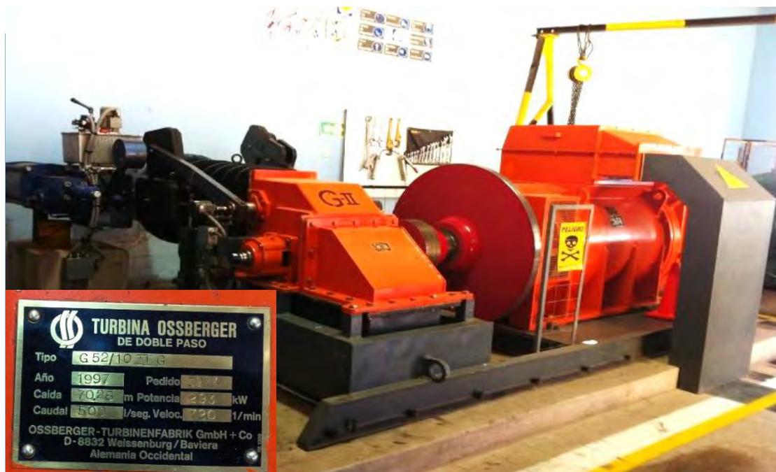
Figura 4.4 Unidad de generación (Turbina y placa de datos grupo 2)
