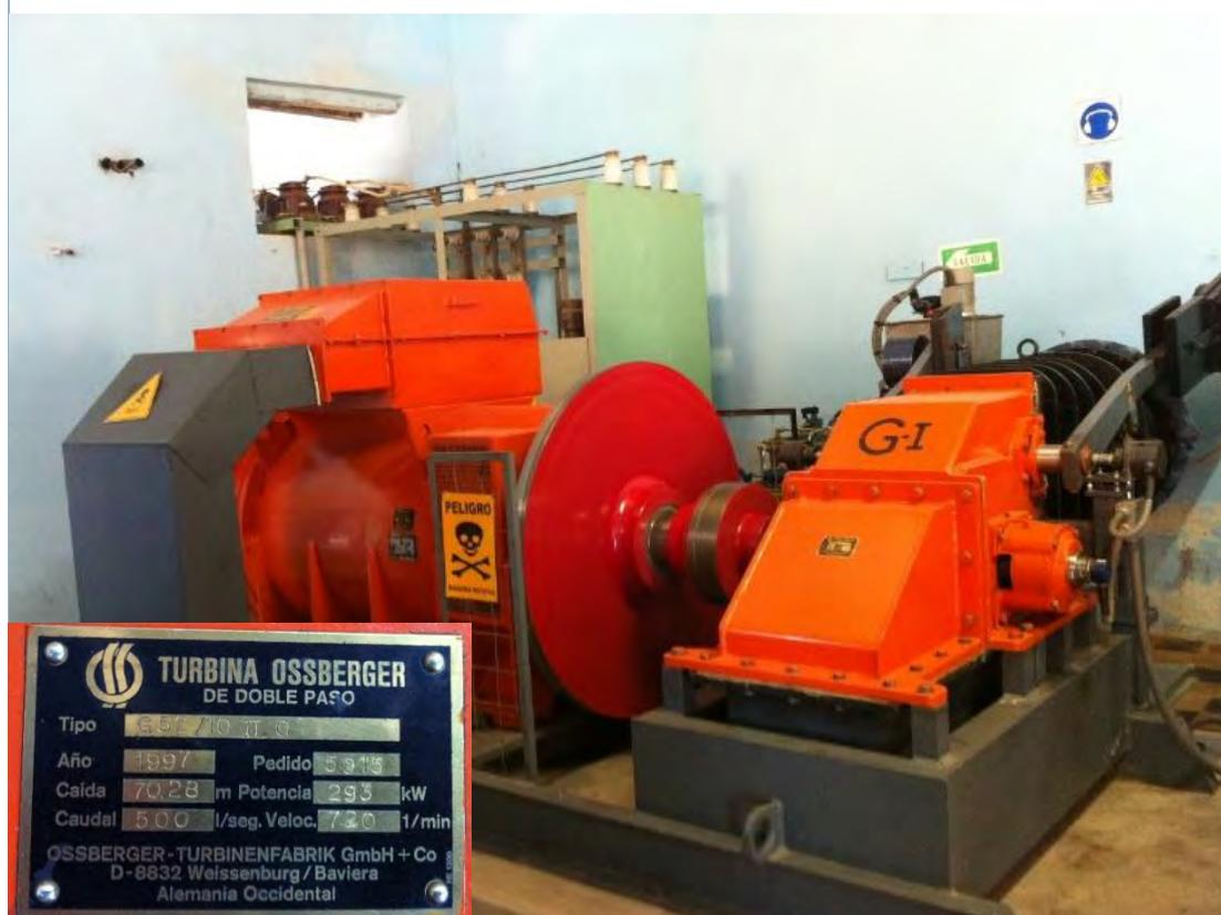
Figura 4.3 Unidad de generación (Turbina y placa de datos grupo 1)
