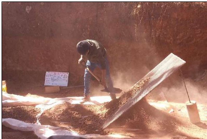
Figura 15. Extracción y zarandeo de suelo para elaboración de unidades de adobe
