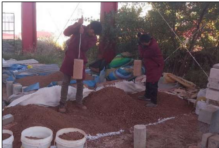
Figura 107. Fragmentación de suelo con herramienta manuales.
