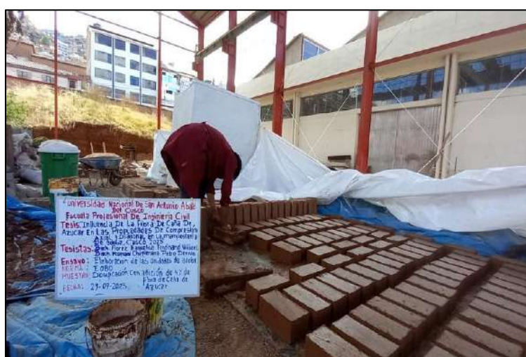
Figura 37. Elaboración de unidades de adobe con adición de 4% de fibra de caña de azúcar.
