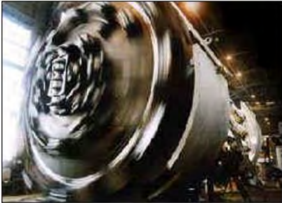
Figura 10. Vista de operación de un TBM
