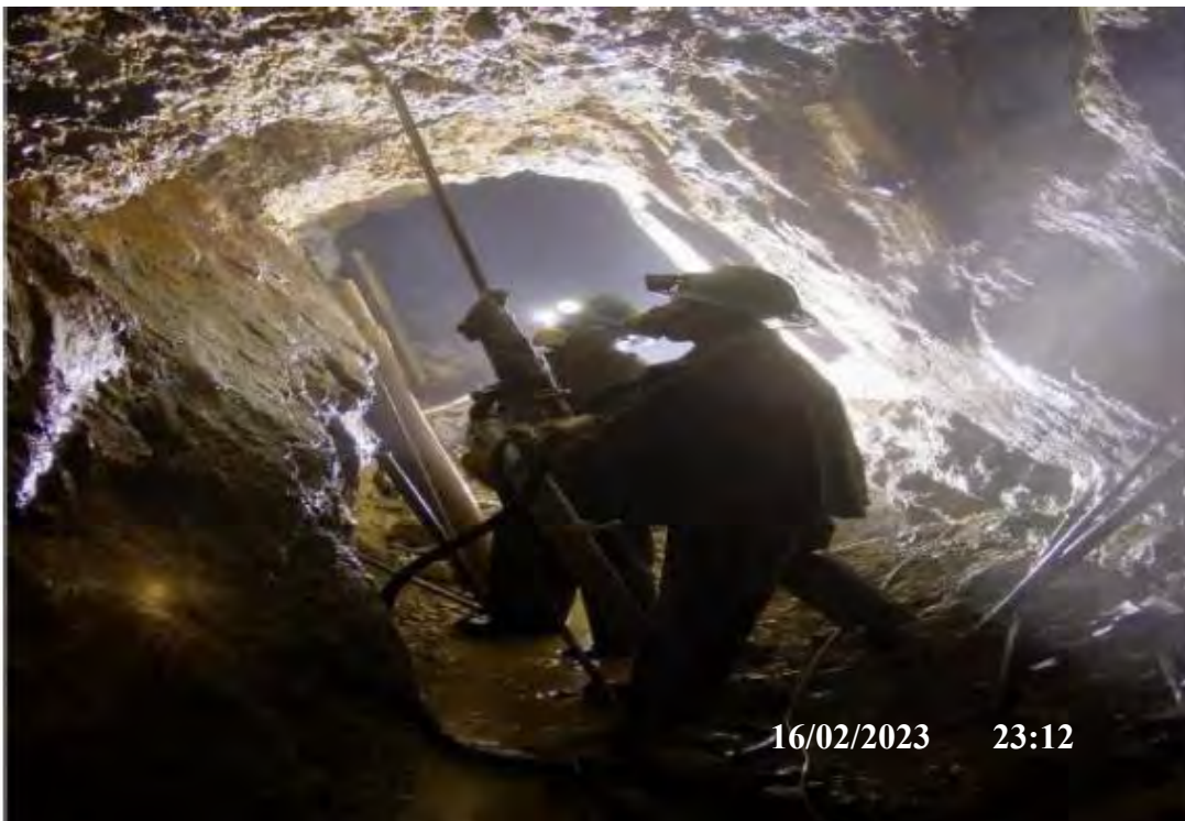
Figura 33. Perforación en vetas
