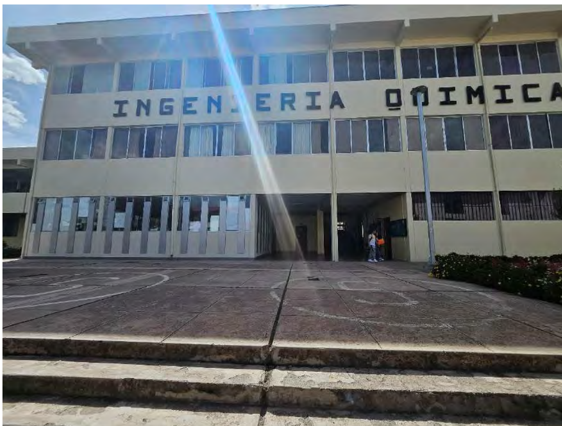
FOTOGRAFÍA N° 05. Edificación de la escuela profesional de Ingeniería Química
