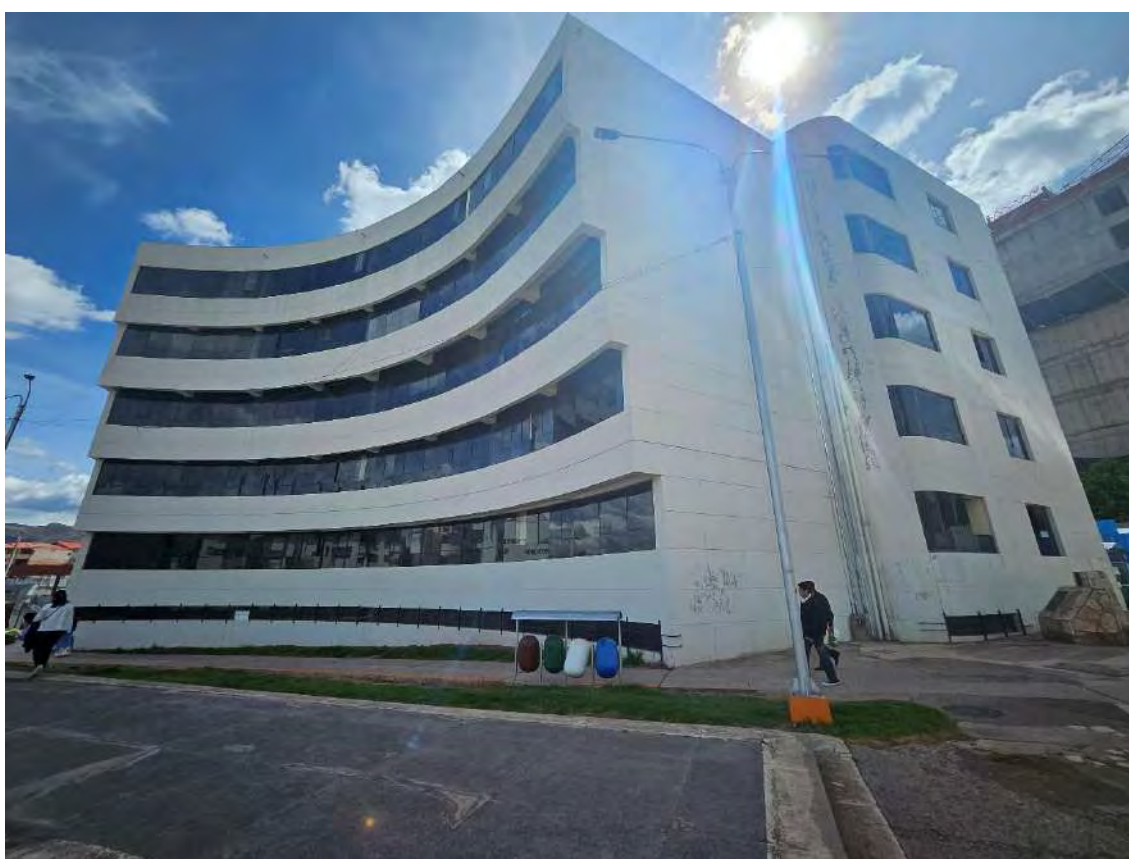
FOTOGRAFÍA N° 10. Edificación del Instituto De Idiomas UNSAAC
