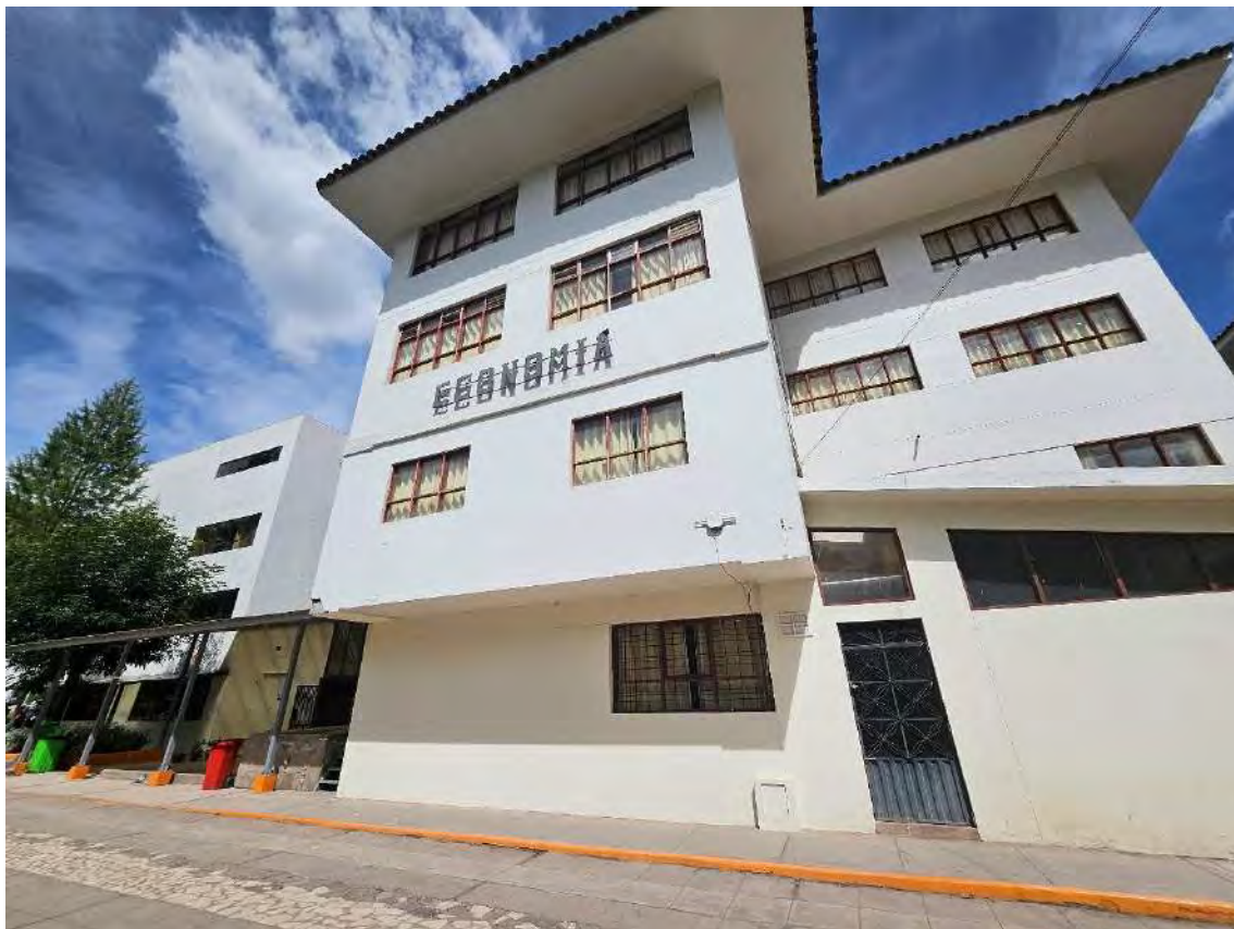
FOTOGRAFÍA N° 11. Edificación de la escuela profesional de Economía
