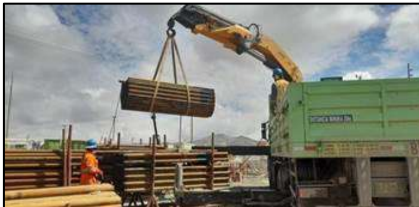
Figura 18: Tubería de perforación
