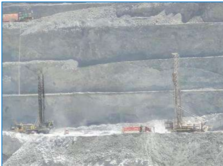
Figura 29: Perforadora eléctrica B & e 49r-diesel.
