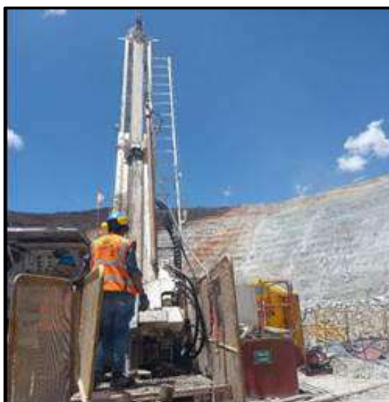
Figura 17: Maquina perforadora geo 300 en operación tajo Norte Antapaccay
