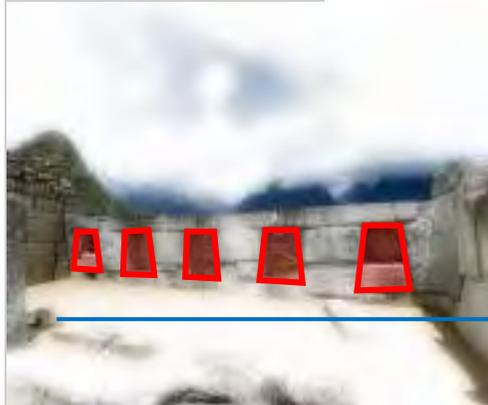
También observamos la inclinación de 5° en los vanos incas, donde se aprecia también la forma trapezoidal al igual que los muros. Además notamos la repetición de su vanos en formas trapezoidales los cuales van en un rango de 3 a 7 repeticiones, siendo lo mas empleado 5 repeticiones.
